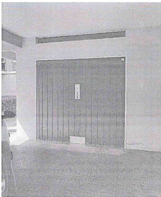
Foto 1: Vista prospetto garage
