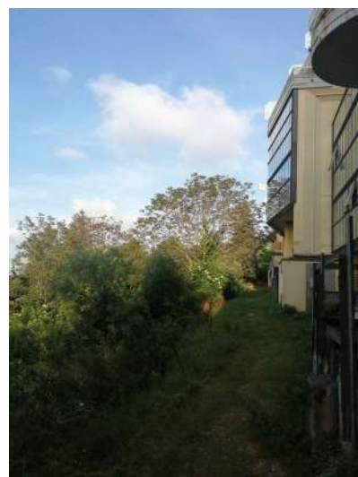
porzione fronte Nord
