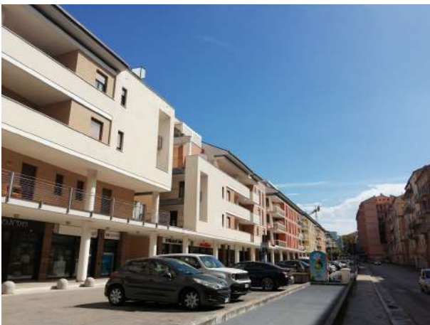
fronte su via Trento
