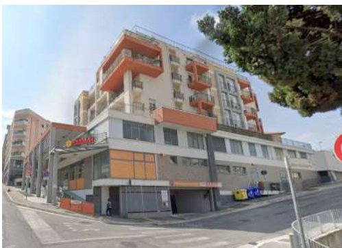
vista da via dei Velini
