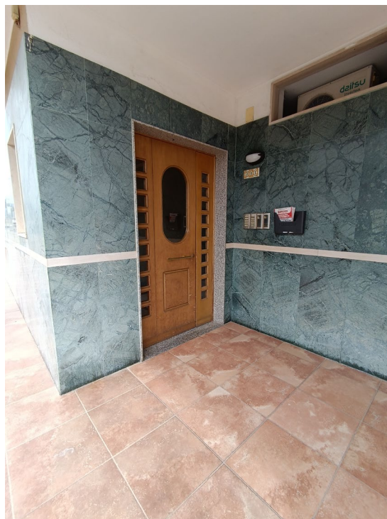
Vista dell'accesso al vano scala I
