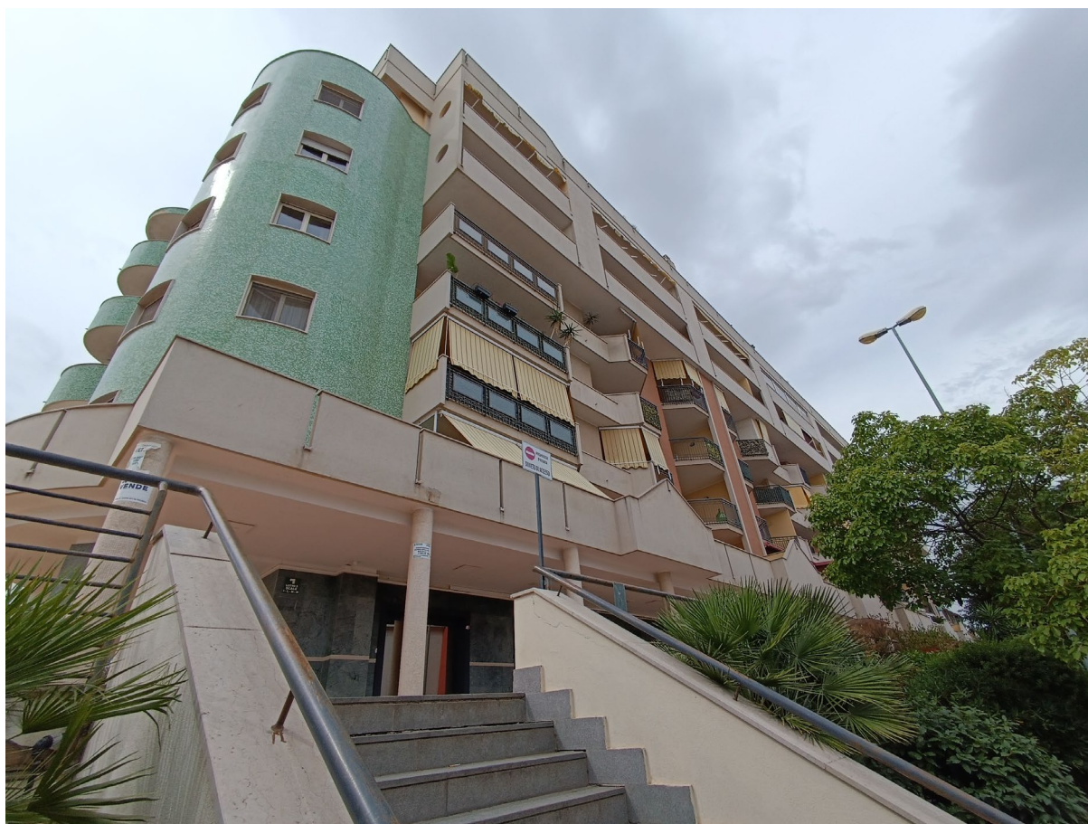
Vista del fabbricato ove insiste l'unità immobiliare in quinto piano
