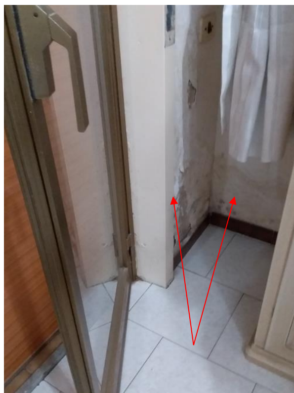
Foto n. 18 - Umidità di risalita nella camera da letto.
