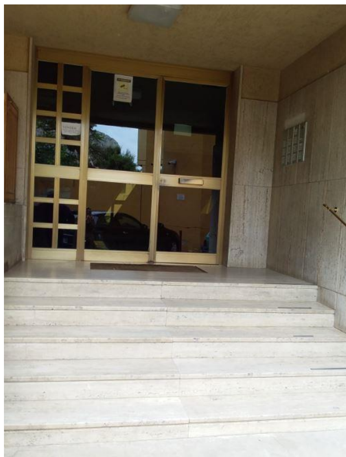
Foto n. 5 - Ingresso allo stabile condominiale.
