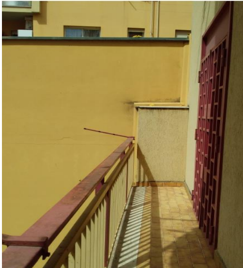
Foto n. 14 - Balcone a sud.
