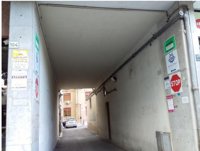
Foto n. 1 - Passaggio coperto che si apre sulla via Imperatore Federico e porta al civico 106.
