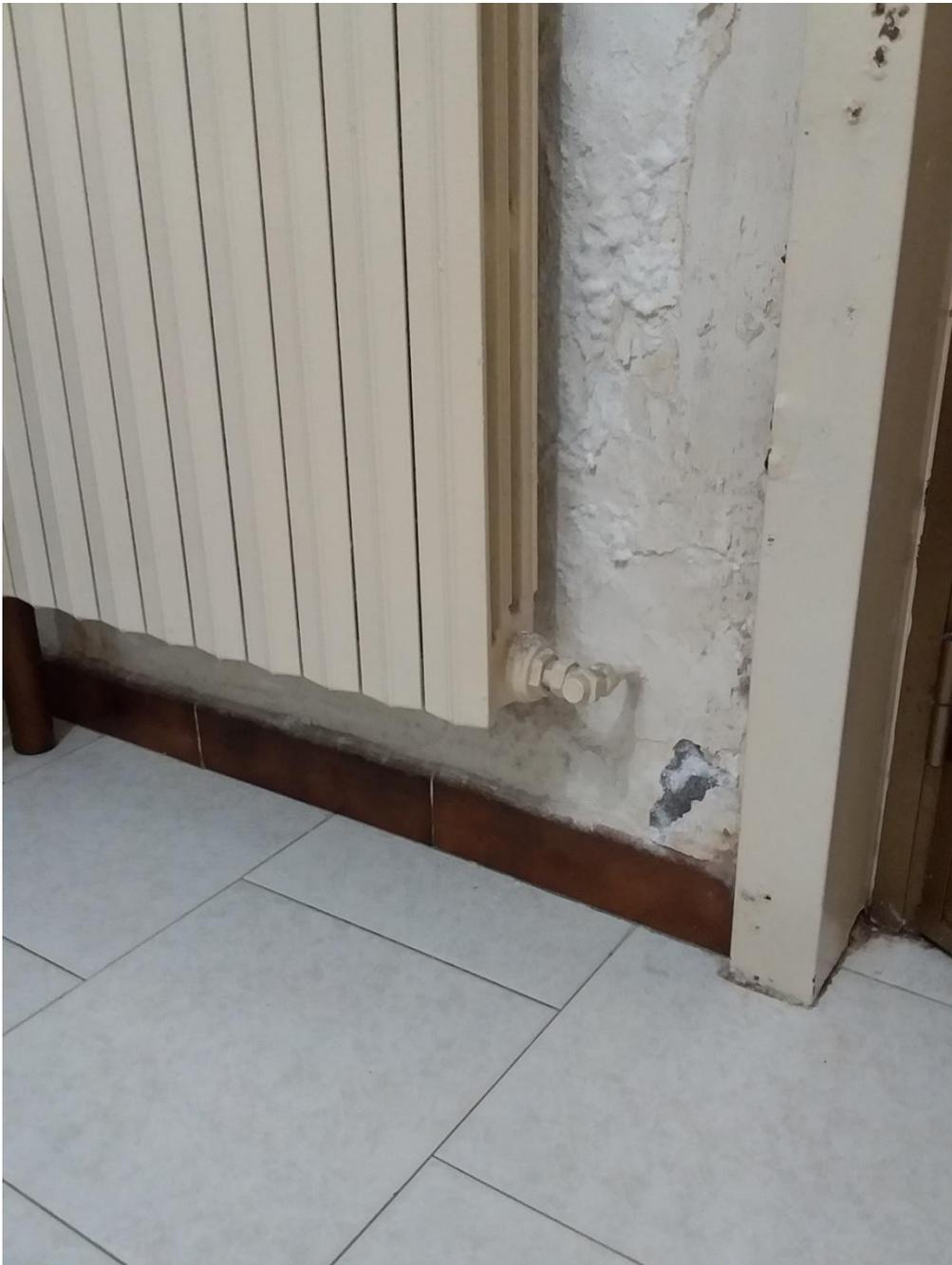
Immagine 22 - Foto del 6 giugno 2019: danni da umidità sul muro della camera a N.
