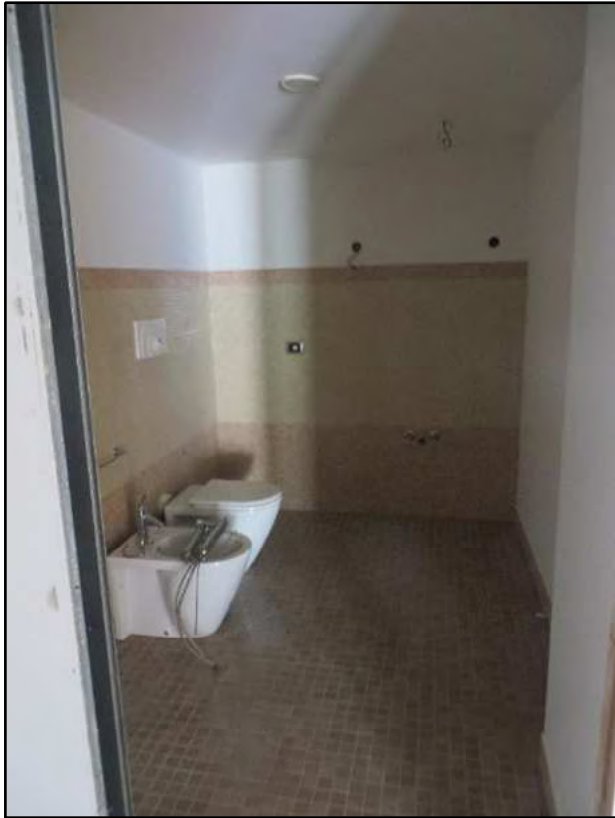
Servizio igienico ubicato in prossimità dell'ingresso
