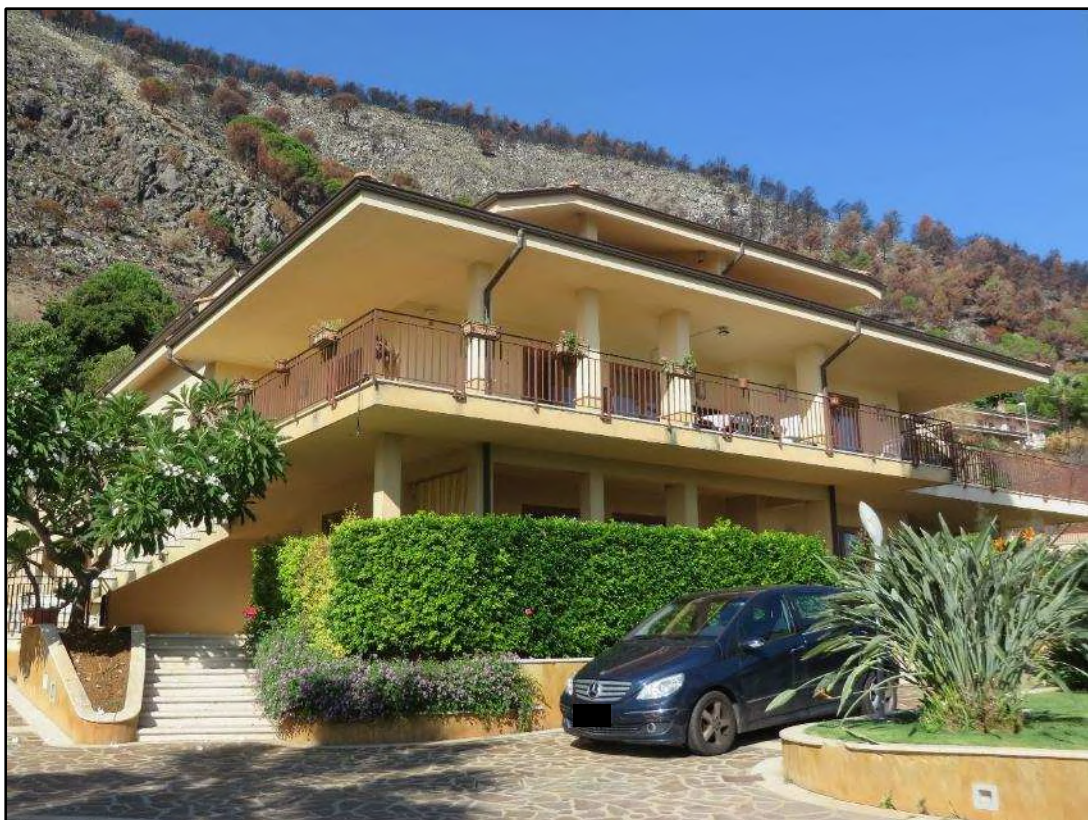
Edificio in cui insiste l'immobile oggetto di stima
