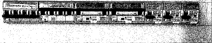
Quattro interruttori magnetotermici quadripolari rispettivamente per linea cantiere vecchio, quadro uffici, generale basette sx, generale basette dx;
