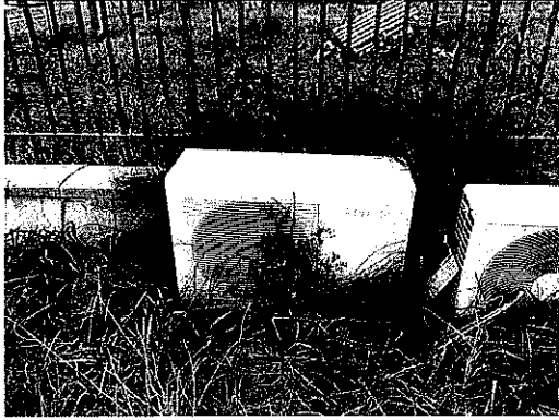
Unità esterna moto condensante
