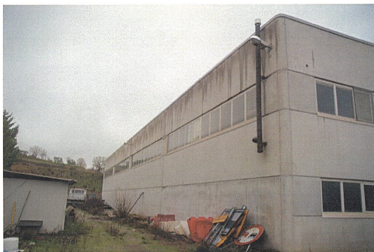
Foto n°6: vista lato Sud-Ovest dello stabile.
