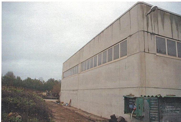
Foto n°7: particolare del lato Nord.
