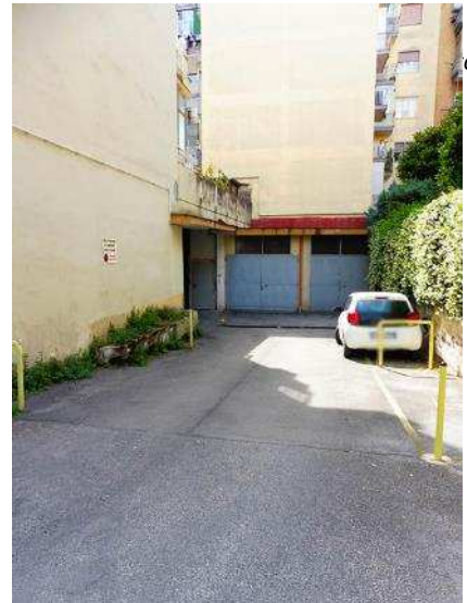
_vialetto di accesso al piano primo sottostrada
