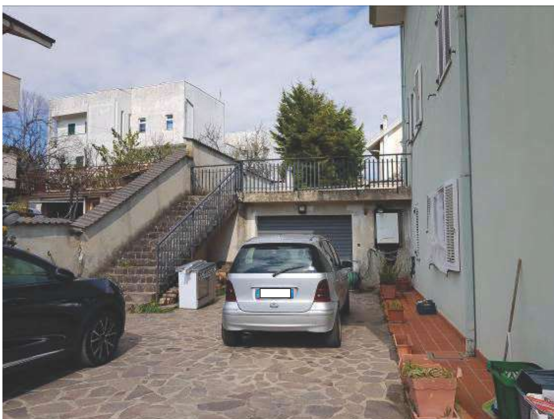
INGRESSO AL GARAGE E SCALE CHE COLLEGANO IL PIANO TERRA ALLA CORTE DEL PRIMO PIANO
