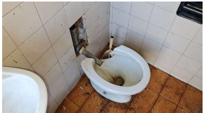
14. Particolare sanitari servizio igienico esterno
