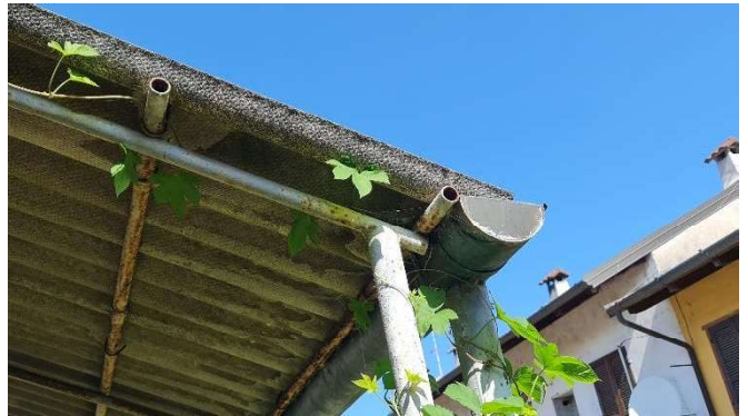
12. Particolare copertura tettoia in Eternit
