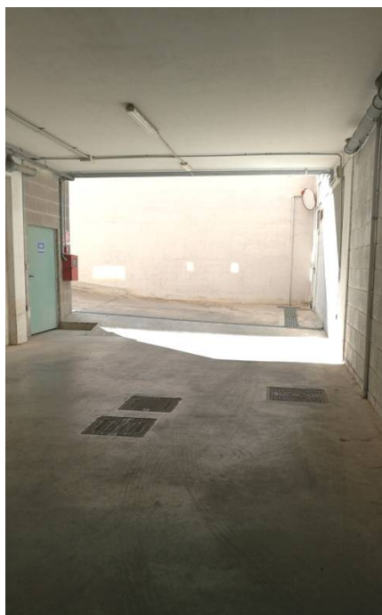
Figura 15 – Vista dall'interno del vano di accesso al corridoio
