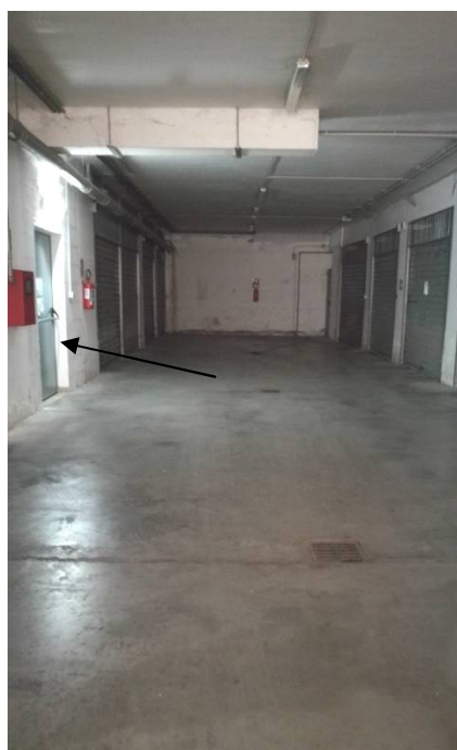
Figura 16 – Corridoio di manovra e accesso dalla vano scale E
