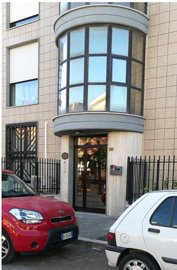
Figura 3 – Dettaglio del portone di accesso e della vetrata sovrastante
