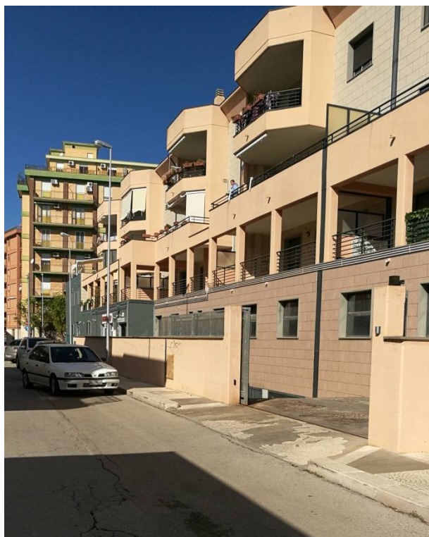
Figura 13 – Cancello di accesso ai box da Via G. La Pira
