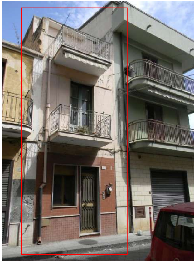
Figura 2: prospetto dell'immobile su Via Cavour
