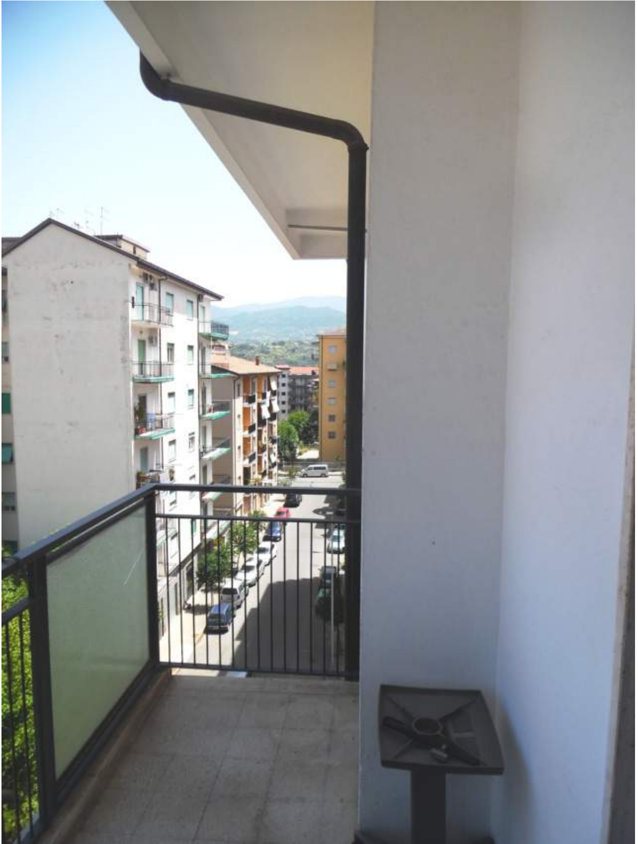
Foto 19: balcone che si affaccia su via Stanislao Amato - Lato Nord
