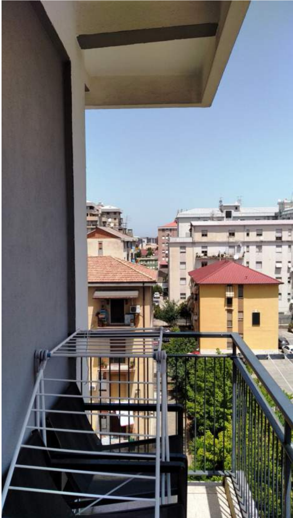
Foto 26: balcone annesso a stanza da letto - affaccio lato Est
