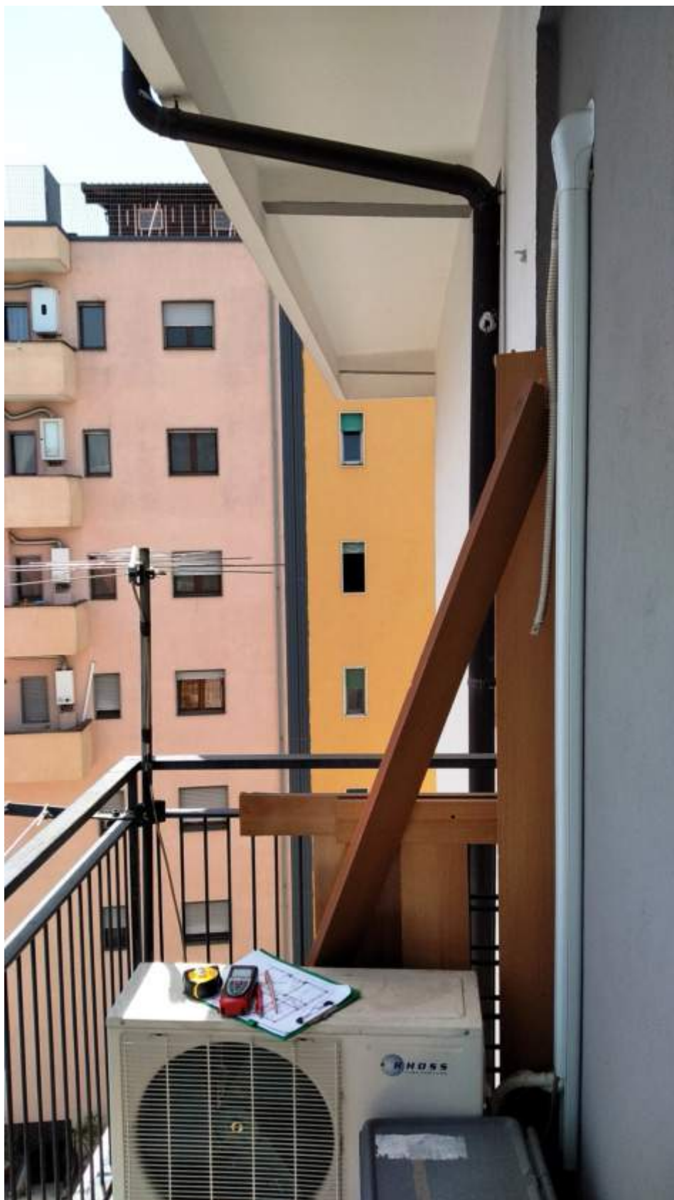
Foto 27: balcone annesso a stanza da letto - affaccio lato Est
