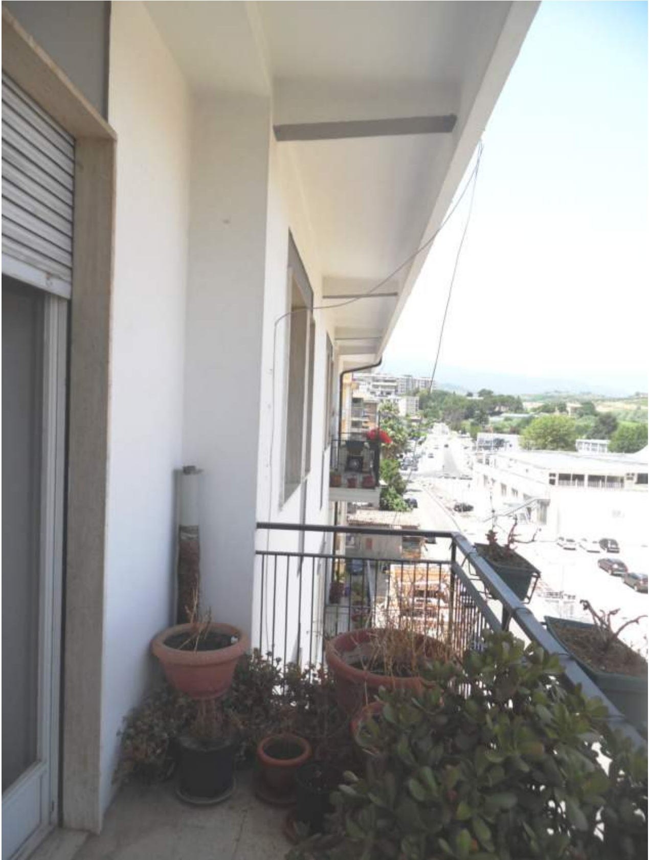
Foto 18: balcone che si affaccia su via Stanislao Amato - Lato Nord
