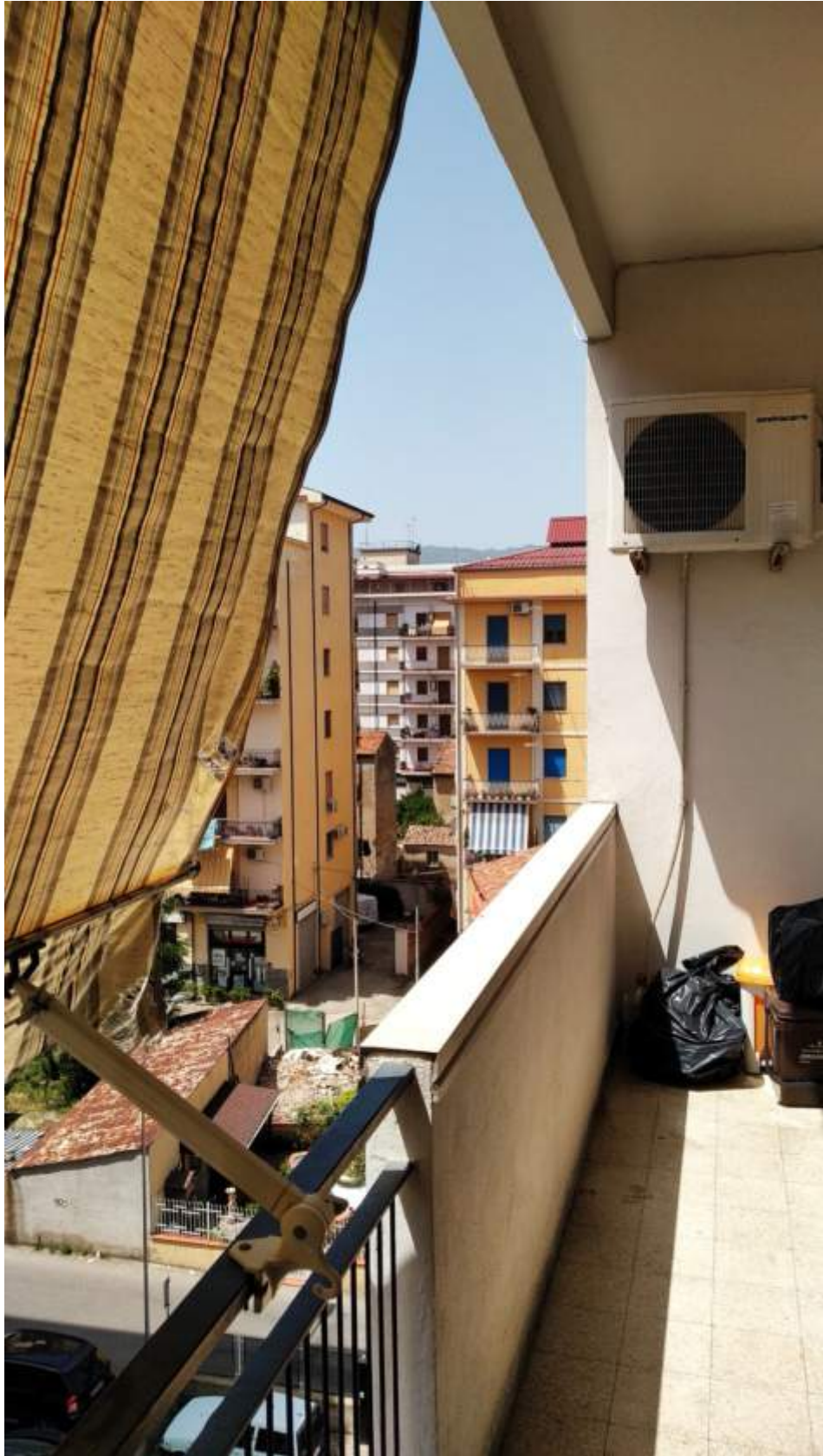
Foto 28: balcone annesso alla cucina - affaccio lato Sud
