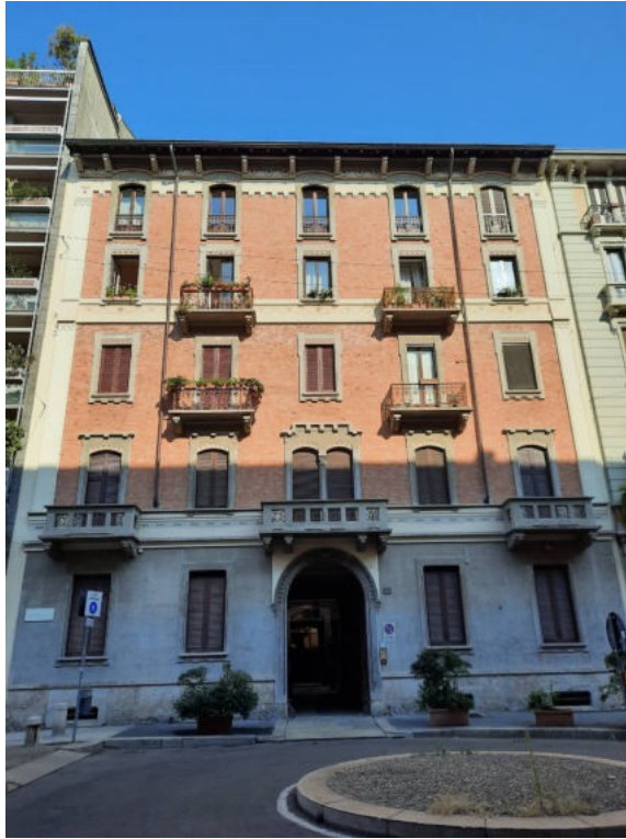
FOTO 1 –Milano edificio Via Francesco Petrarca 24
