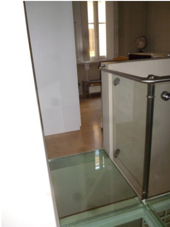
FOTO 10 – Sbarco scala piano 2 e disimpegno
