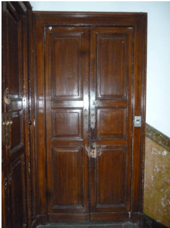
FOTO 2 – Ingresso principale abitazione piano 1
