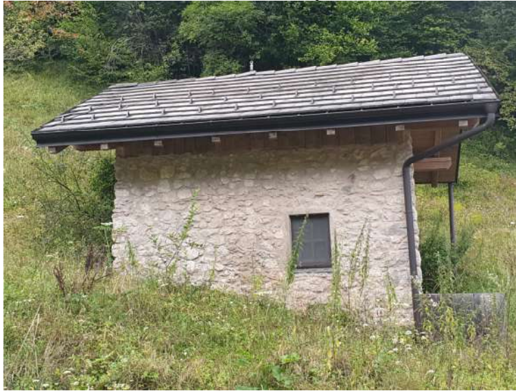
VISTA DA NORD VERSO SUD (strada sterrata/piazzale)
