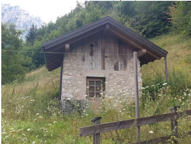
PROSPETTO NORD (deposito)
