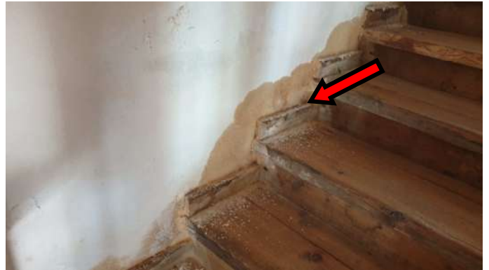
SCALA ACCESSO AL SOPPALCO
