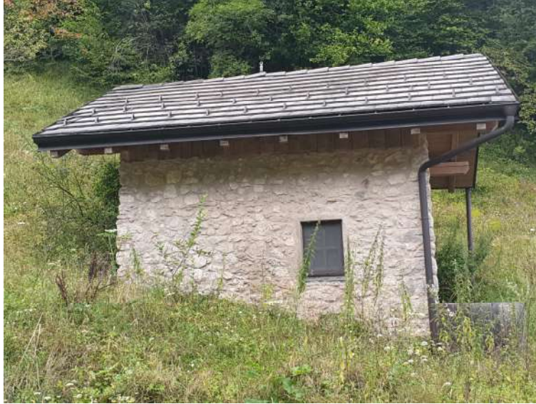
VISTA DA NORD VERSO SUD (strada sterrata/piazzale)
