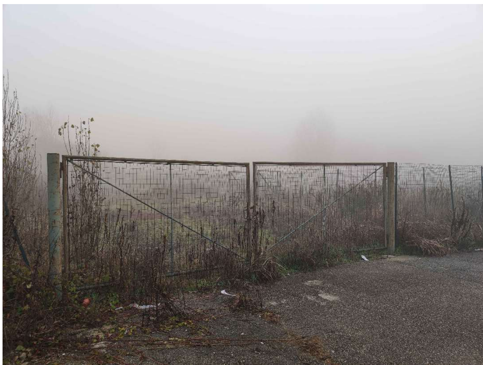
Fot. 8 – Vista esterna del bene
