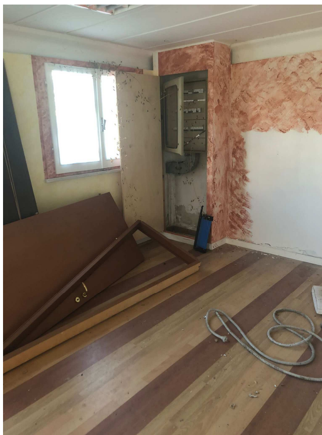
Foto 5. Prefabbricato ad uso ufficio – piano terra
