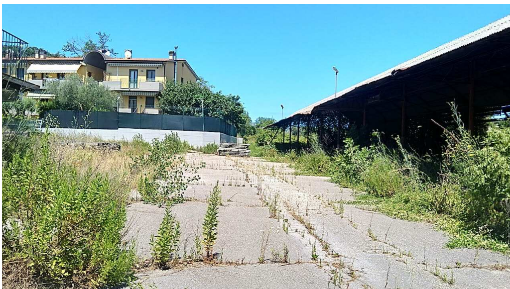
Foto 2. Piazzale interno asfaltato
