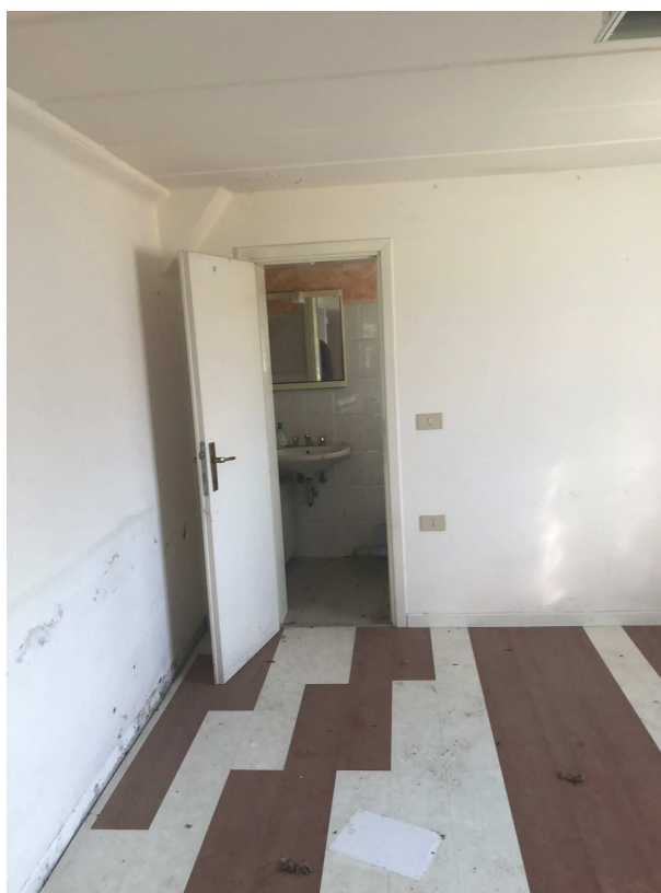
Foto 6. Prefabbricato ad uso ufficio – piano terra
