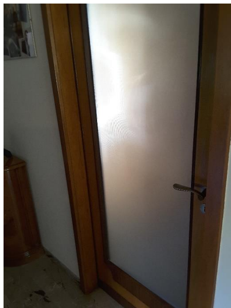
Vista porte interne
