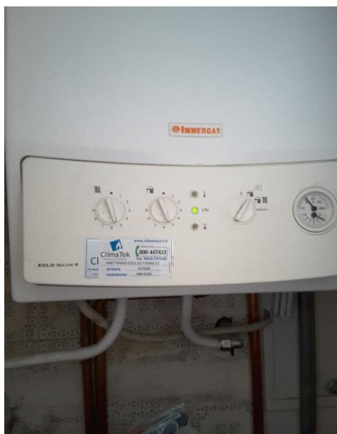
Impianto di riscaldamento costituito da caldaia a gas metano
