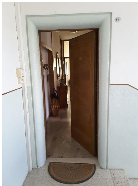
Vista portino blindato con pannellatura esterna in legno che si apre sul corridoio di ingresso
