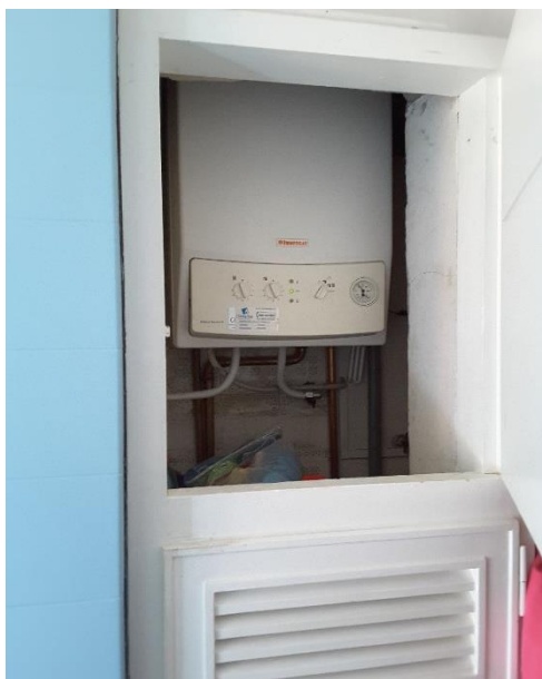
Impianto di riscaldamento costituito da caldaia a gas metano
