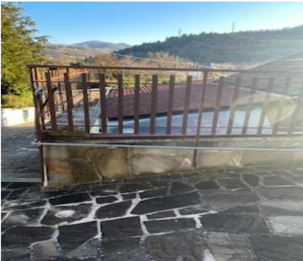
ESTERNO RETROSTANTE IL FABBRICATO
