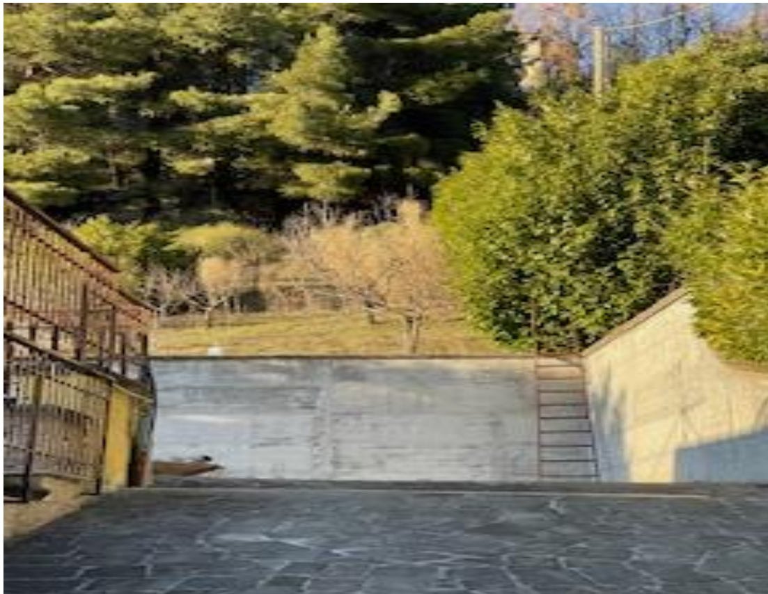
ESTERNO MURO DI CONTENIMENTO TERRENO
