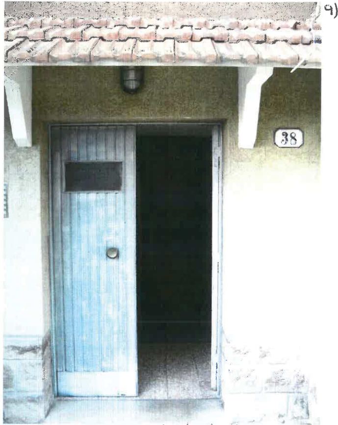
ingresso di fabbricato
