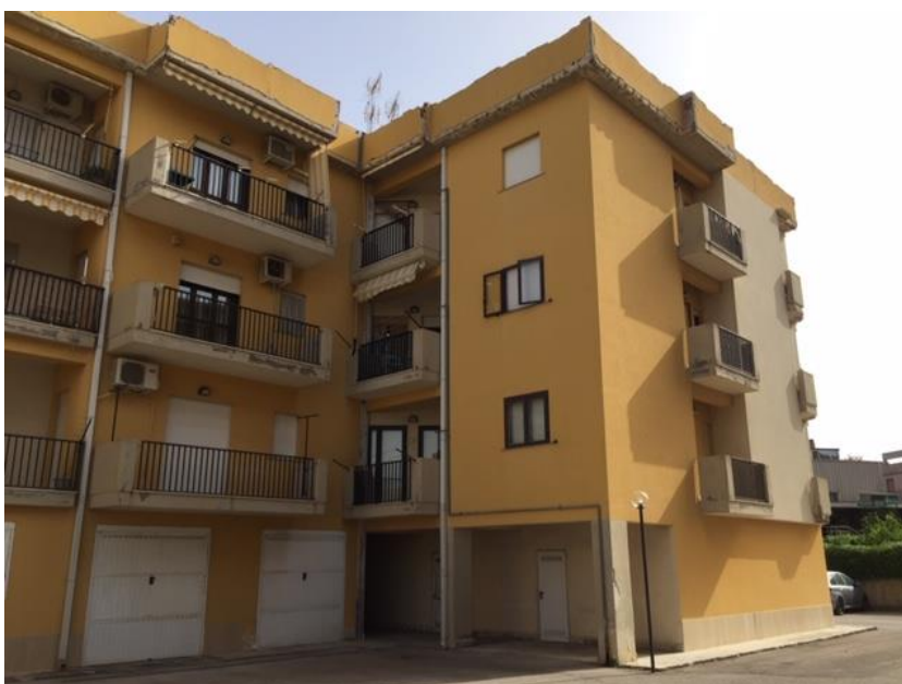
Foto 8. Prospetto su corte comune.
