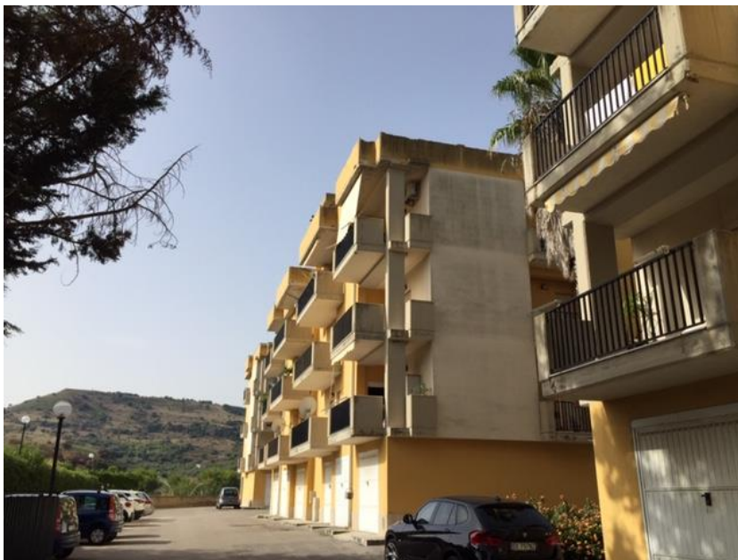
Foto 7. Prospetto su corte comune.
