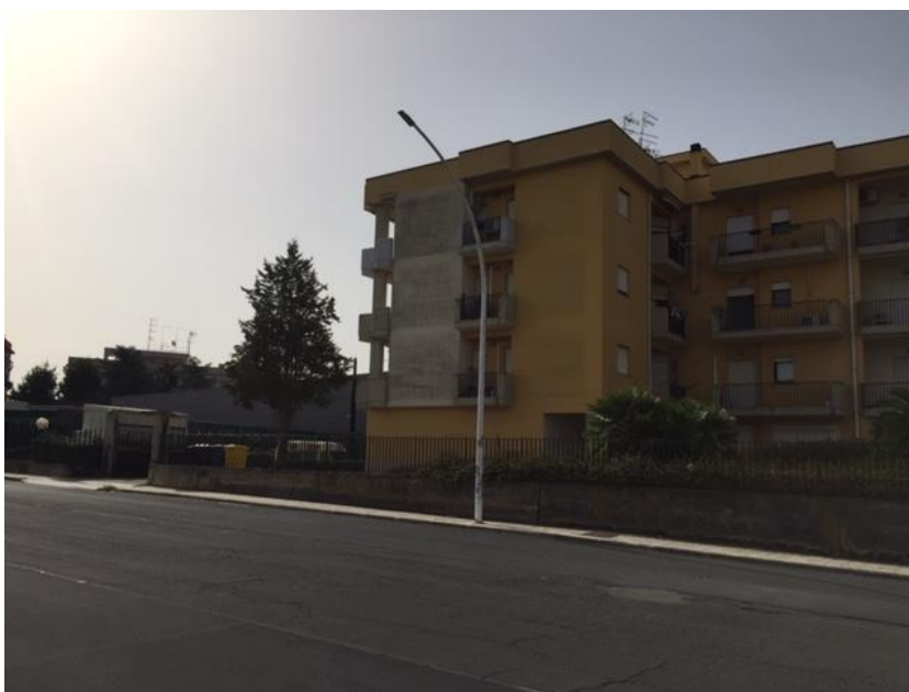
Foto 2. Vista esterna del complesso residenziale su via Sebastiano Battaglia.
