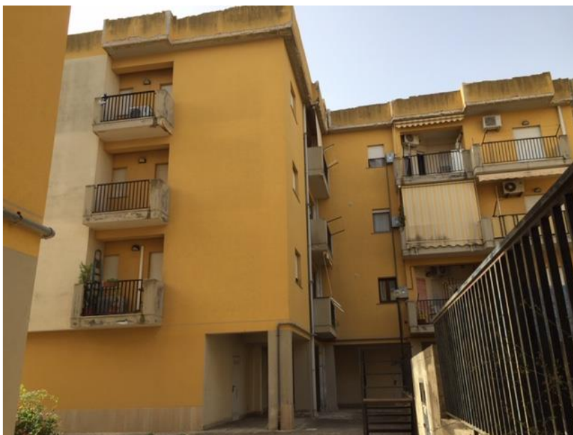
Foto 10. Prospetto su corte comune.
