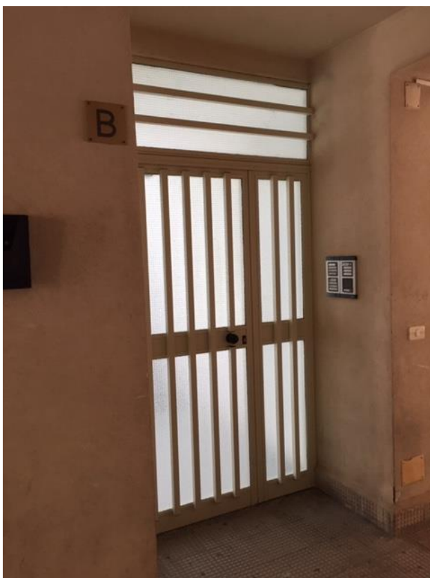
Foto 13. Portone di ingresso all'edificio scala B.
