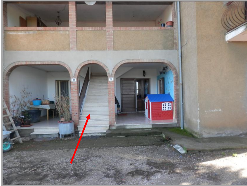
Foto " 20 " – Vista della corte a comune con altre Unità Immobiliari e dell'accesso all'immobile
