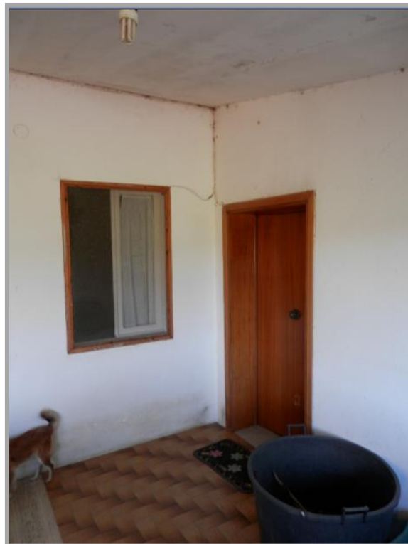
Foto " 21 " – Vista della veranda
