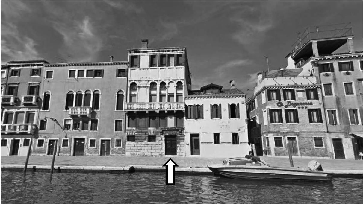
Vista del prospetto con indicato l'ingresso al Laboratorio
