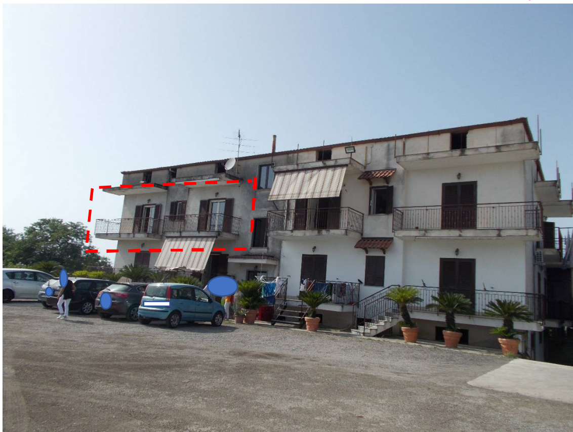
1 - Vista del fabbricato dalla corte interna
