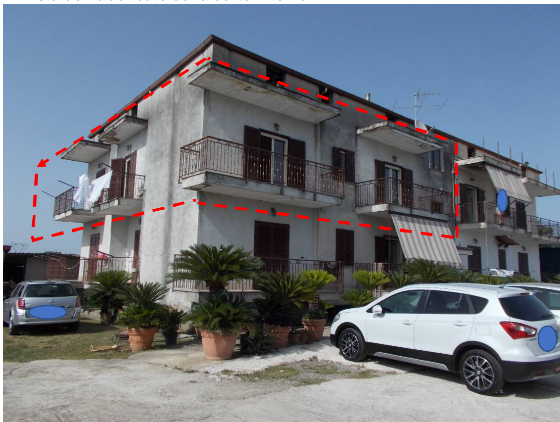
2 - Vista del fabbricato dalla corte interna
