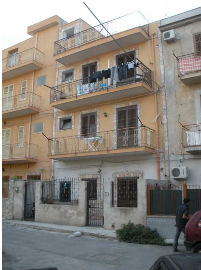
Foto 1 - Prospetto su Largo Petix
