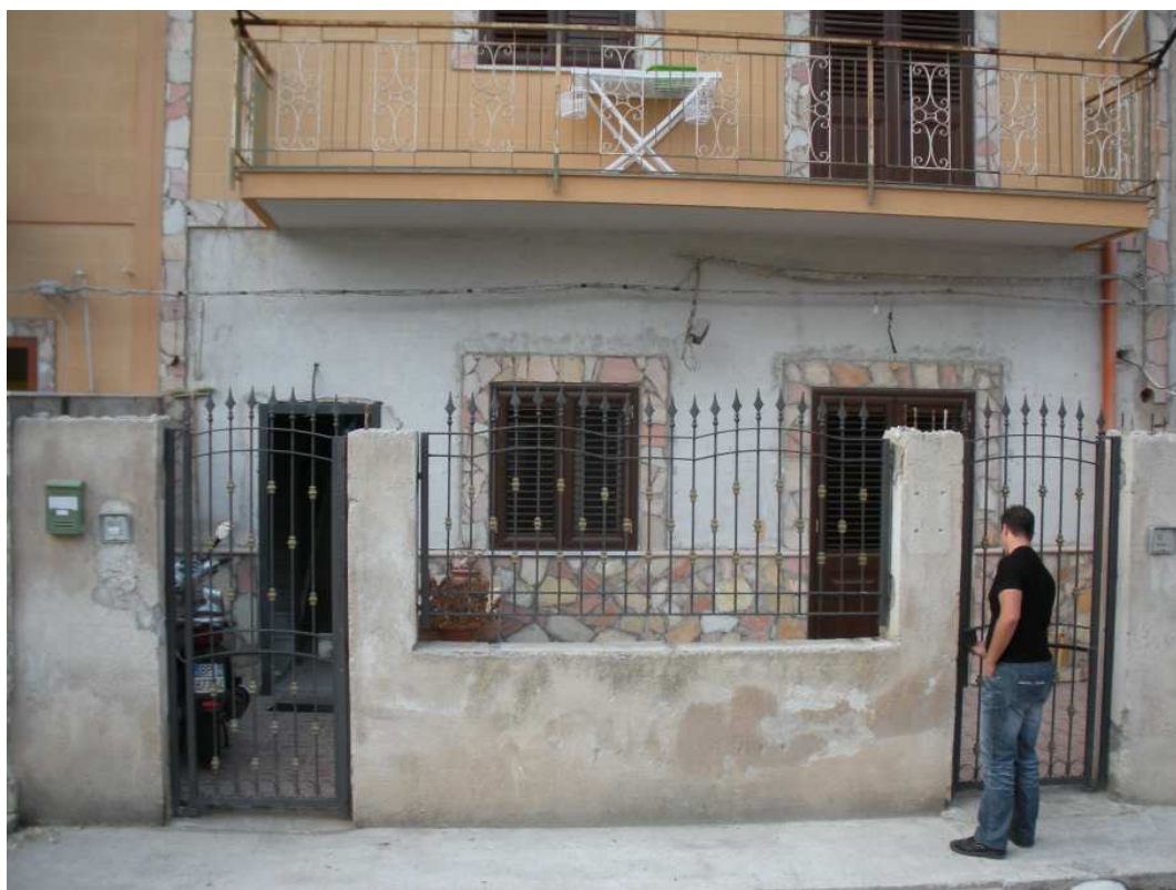
Foto 2 - Ingresso al piano terra da Largo Petix n. 9
