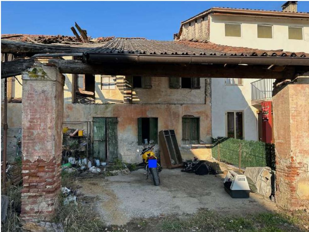
Dettaglio fronte sud.
