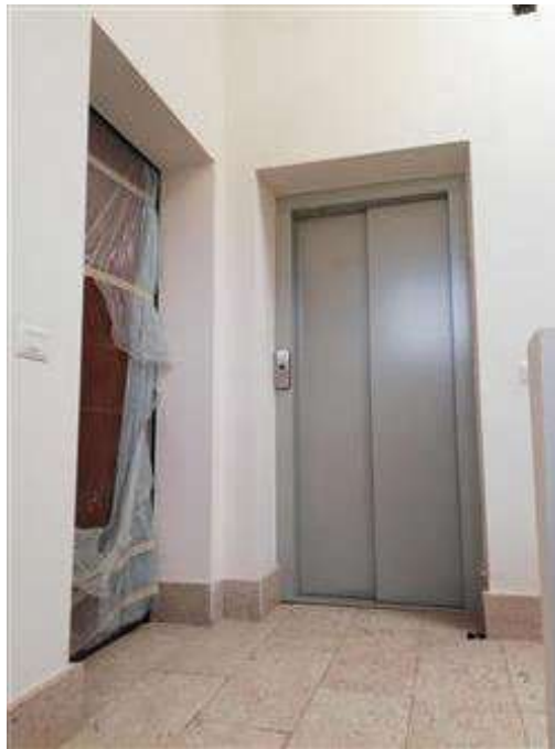
Ingresso immobile da vano scala condominiale
