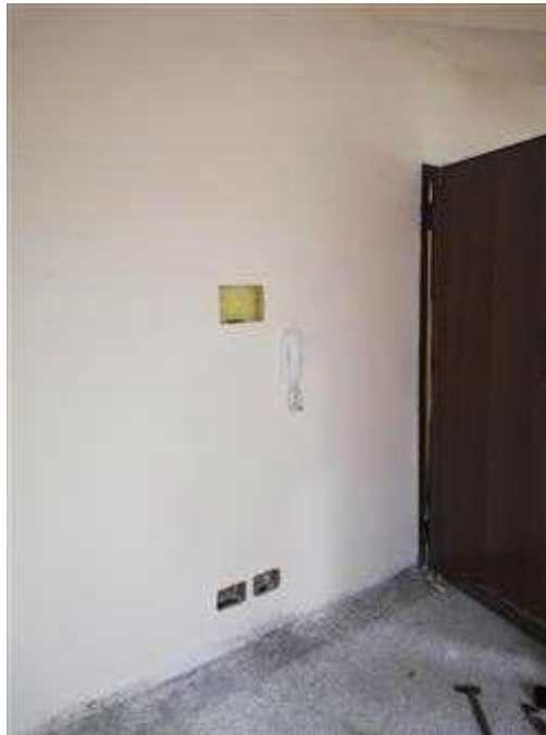
Interno parete a confine con vano scala
