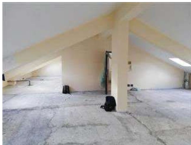
Interno vista direzione sub 50
