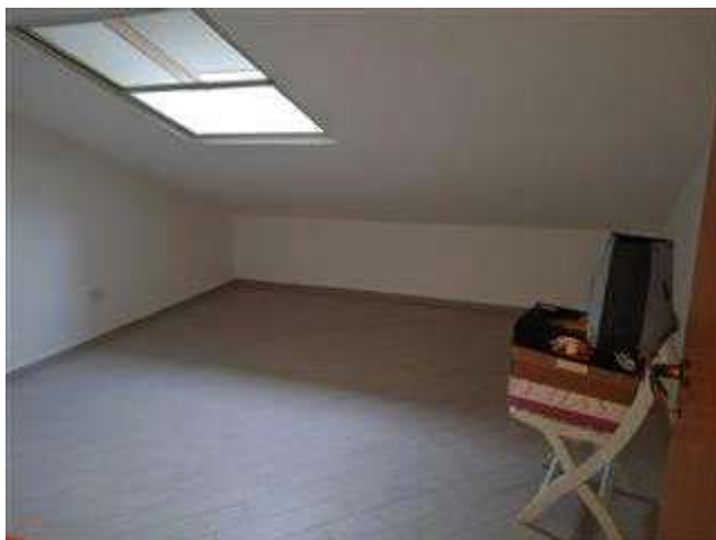
Vano deposito sottotetto
