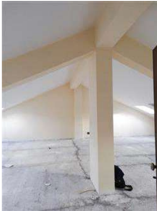
Interno - colpo e parete a confine con sub 109
