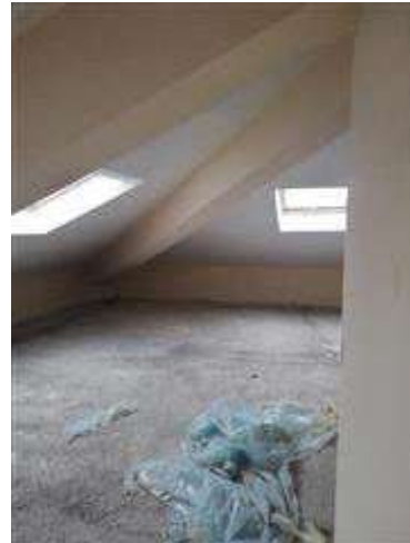
Interno angolo nord/est - sud/est
