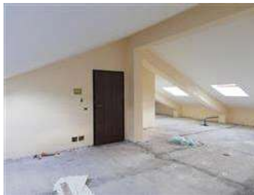
Interno - Ingresso e falda lato sud/ovest
