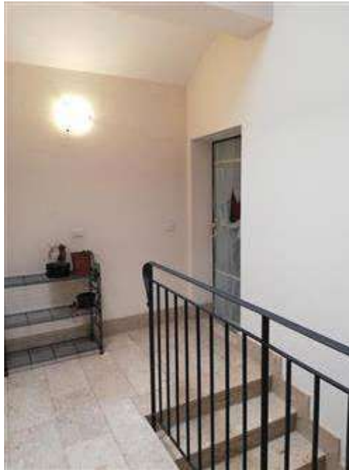
Ingresso da vano scala condominiale
