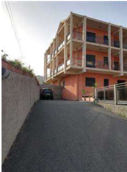
Rampa di accesso all'area del piano terra
