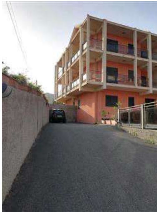
Rampa di accesso all'area del piano terra
