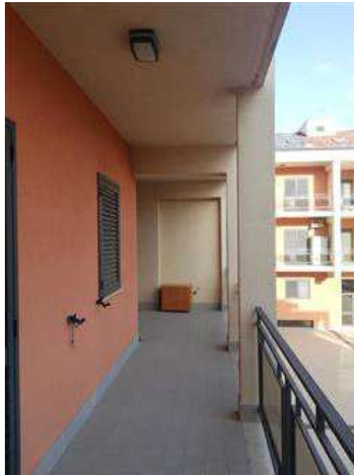
Balcone lato sud/ovest
