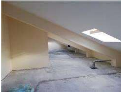
Interno - confine con vano ascensore e sub 51
