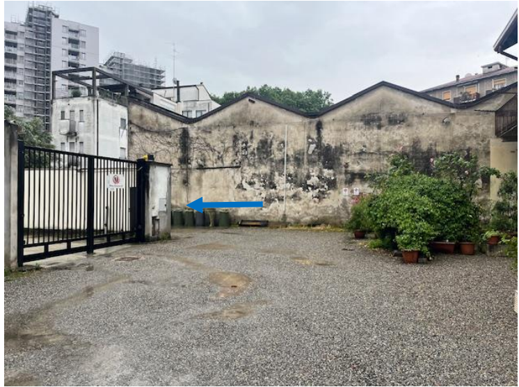
L'immobile in oggetto ed il cortile di proprietà
