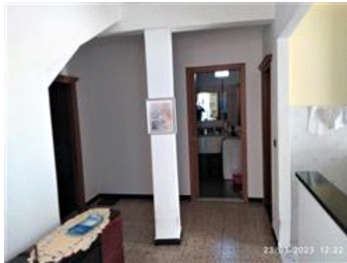
122217 - Piana Crixia, via Chiarlone 27 – Ingresso disimpegno.
