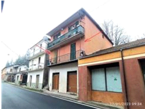
093401 - Pianca Crixia, via Chiarlone 27 – vista, da altra angolazione, del prospetto principale in fregio alla pubblica via. L'abitazione in argomento è al primo piano.
