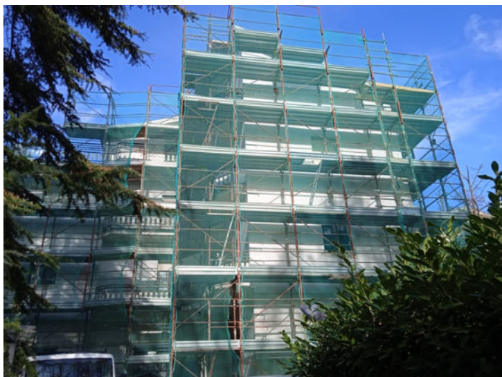
Foto n. 3 – Vista esterna fabbricato - Lato Sud
