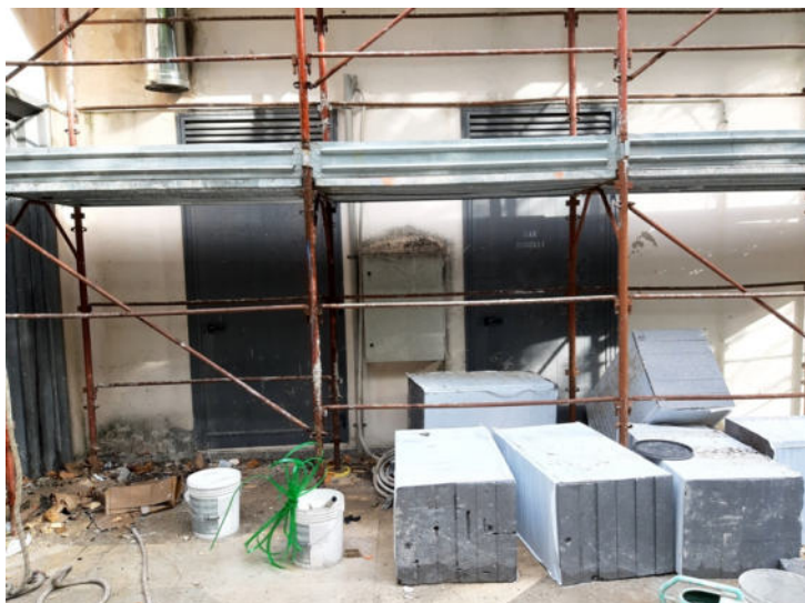
Foto n. 13 – Vista accessi locali tecnici
