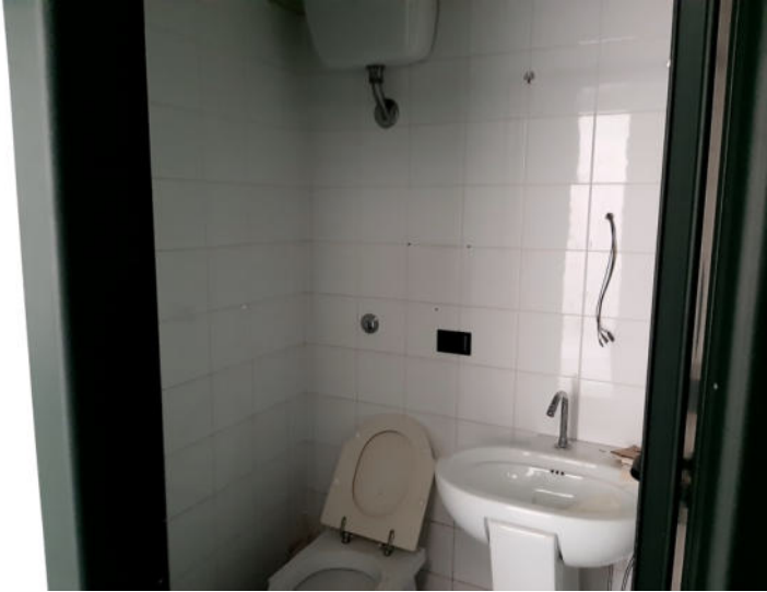
Foto n. 33 – Part. 528 sub 1, 530 e 612 sub 1, graffate - Servizi igienici
