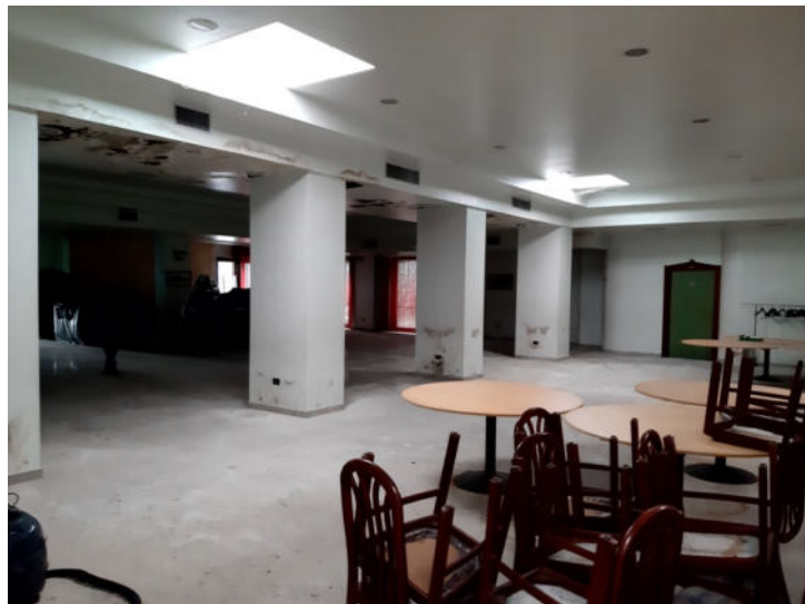
Foto n. 22 – Part. 528 sub 1, 530 e 612 sub 1, graffate - Sala ristorante
