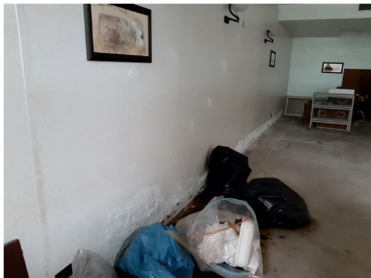
Foto n. 26 – Part. 528 sub 1, 530 e 612 sub 1, graffate - Sala ristorante
