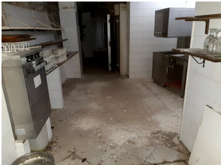
Foto n. 39 – Part. 528 sub 1, 530 e 612 sub 1, graffate - Area dispensa
