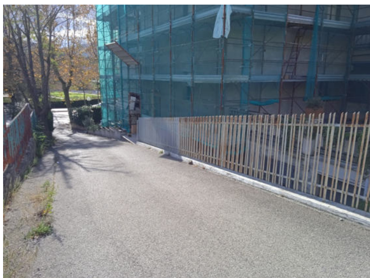
Foto n. 6 – Vista esterna fabbricato - Lato Est
