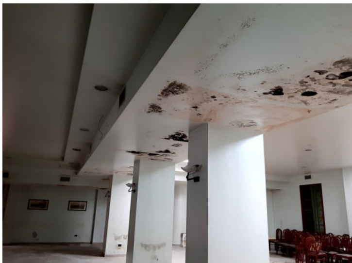
Foto n. 23 – Part. 528 sub 1, 530 e 612 sub 1, graffate - Sala ristorante
