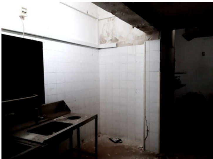
Foto n. 41 – Part. 528 sub 1, 530 e 612 sub 1, graffate - Area dispensa
