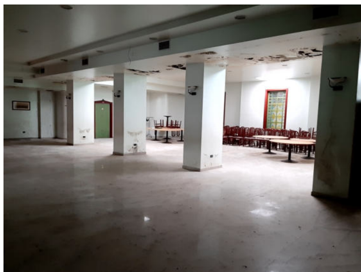
Foto n. 20 – Part. 528 sub 1, 530 e 612 sub 1, graffate - Sala ristorante
