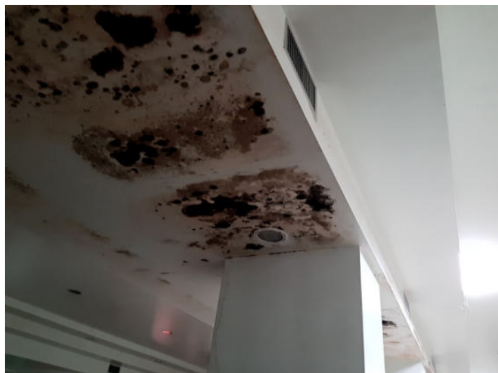
Foto n. 24 – Part. 528 sub 1, 530 e 612 sub 1, graffate - Sala ristorante
