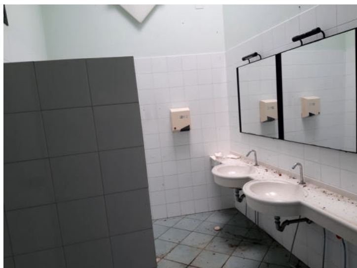
Foto n. 30 – Part. 528 sub 1, 530 e 612 sub 1, graffate - Servizi igienici
