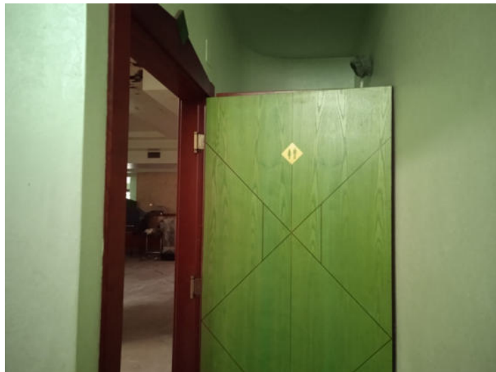
Foto n. 28 – Part. 528 sub 1, 530 e 612 sub 1, graffate - Servizi igienici
