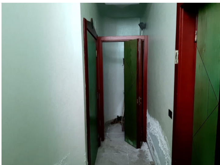
Foto n. 29 – Part. 528 sub 1, 530 e 612 sub 1, graffate - Servizi igienici
