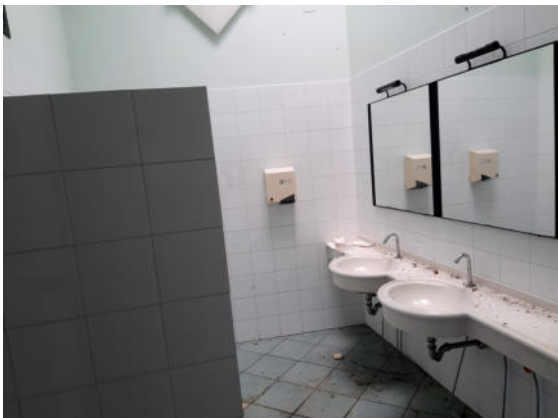
Vista interna servizi igienici
