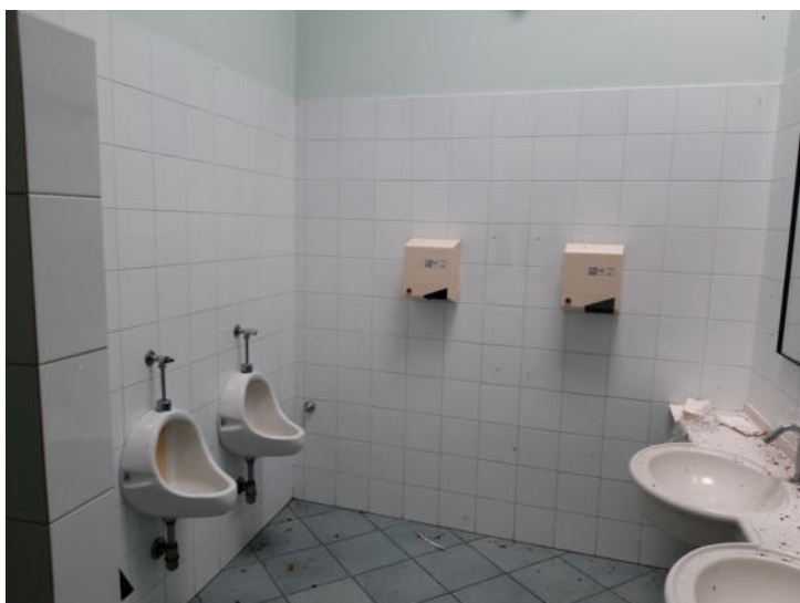
Foto n. 31 – Part. 528 sub 1, 530 e 612 sub 1, graffate - Servizi igienici
