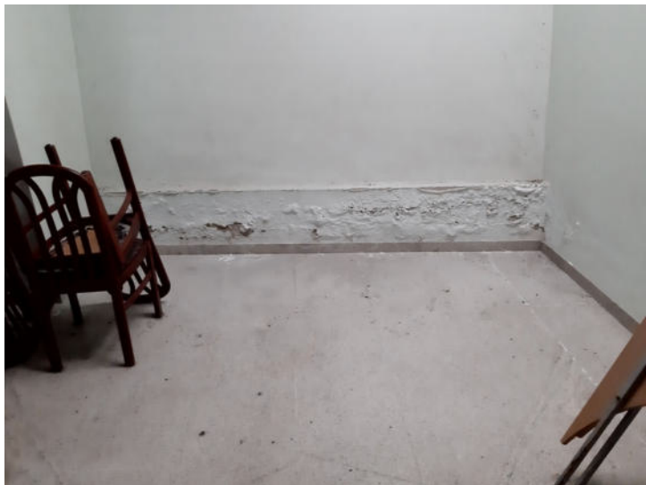
Foto n. 27 – Part. 528 sub 1, 530 e 612 sub 1, graffate - Sala ristorante
