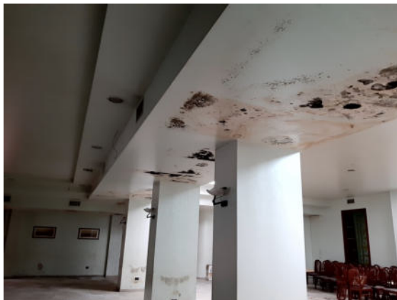
Vista interna sala ristorante
