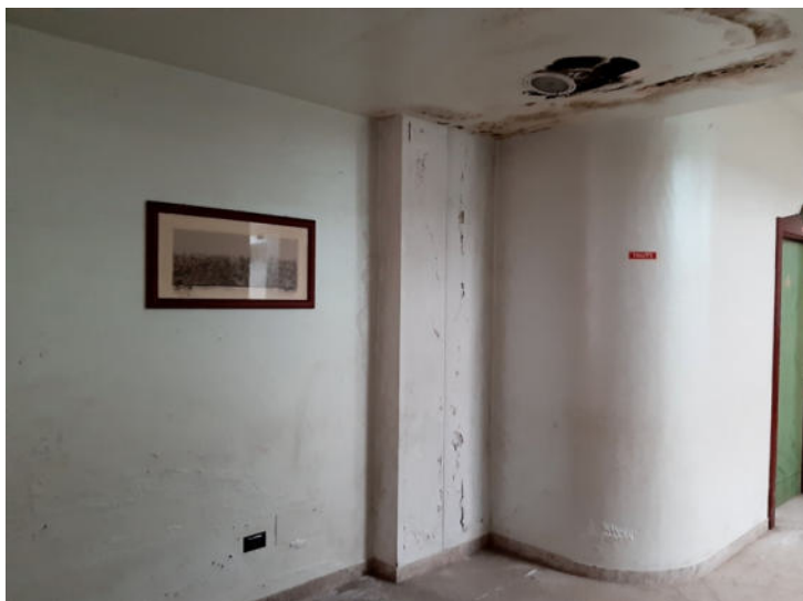
Foto n. 25 – Part. 528 sub 1, 530 e 612 sub 1, graffate - Sala ristorante
