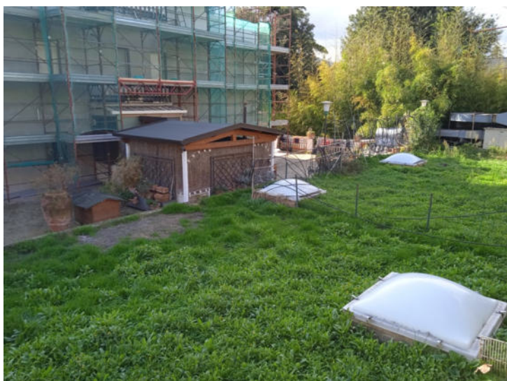
Foto n. 7 – Vista esterna fabbricato - Lato Nord
