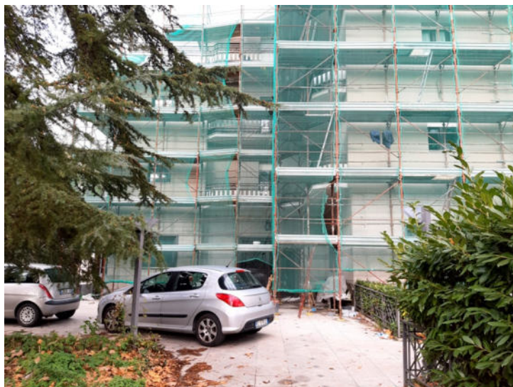
Foto n. 4 – Vista esterna fabbricato - Lato Sud
