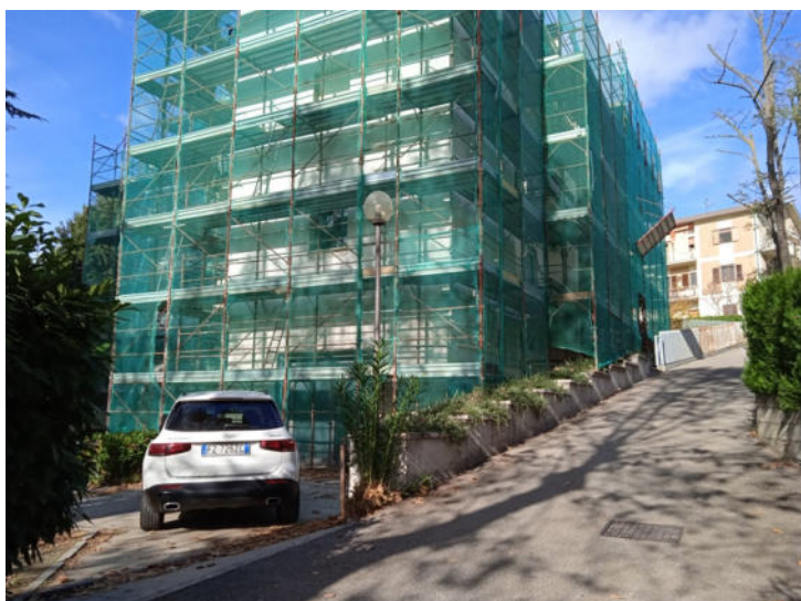
Foto n. 5 – Vista esterna fabbricato - Lato Sud ed Est
