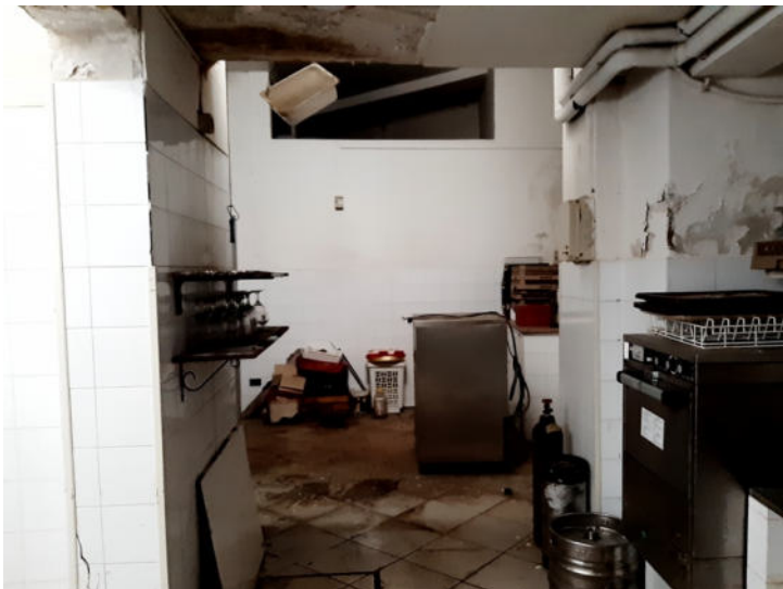
Foto n. 37 – Part. 528 sub 1, 530 e 612 sub 1, graffate - Area dispensa
