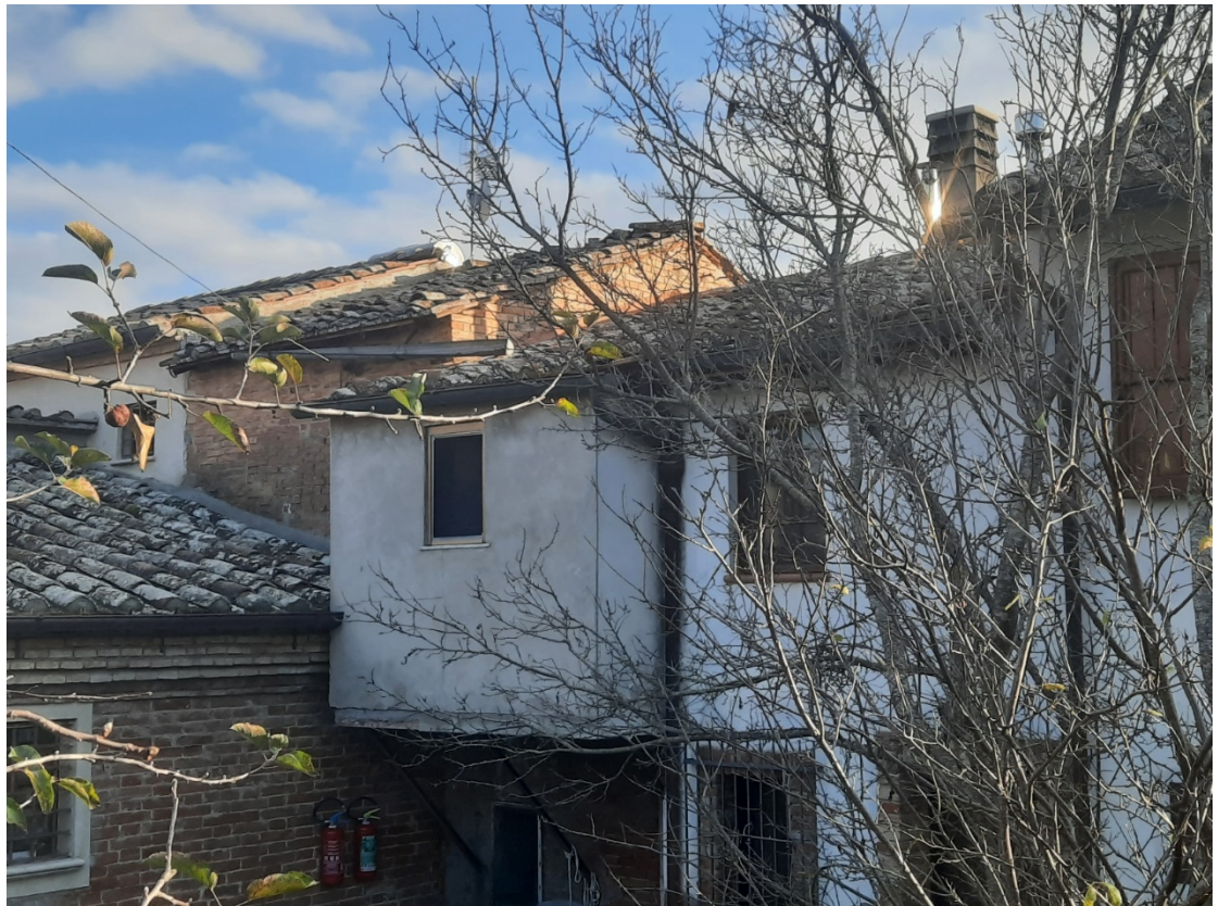
FOTO 4 (vista della copertura)
