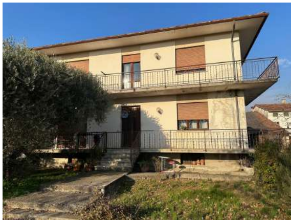
Vista dalla strada (lato sud).
