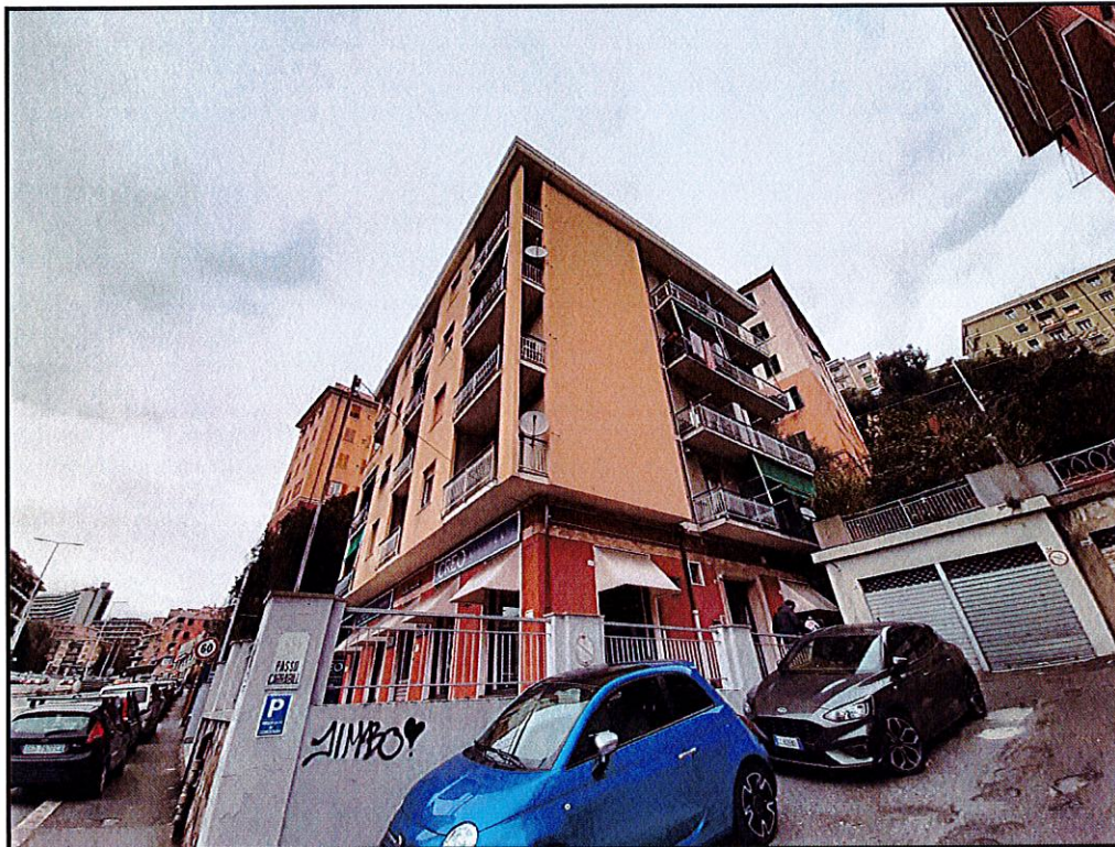
FOTO N. 2 – Corso Europa – Facciata
