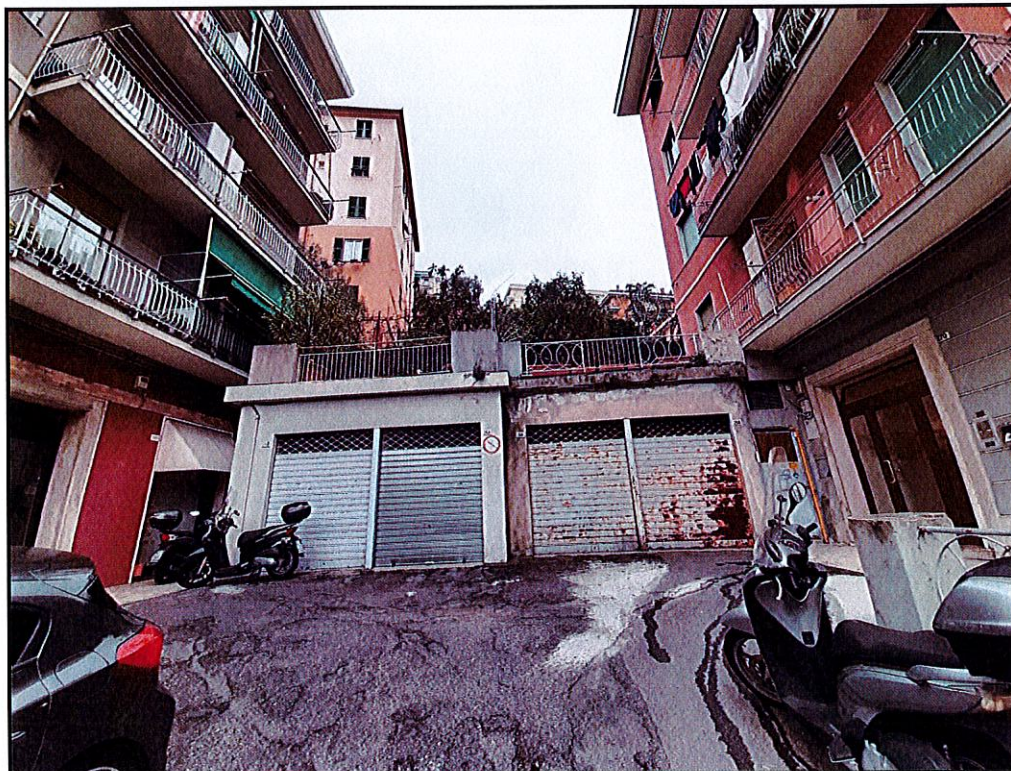
FOTO N. 3 – Piazzale e box
