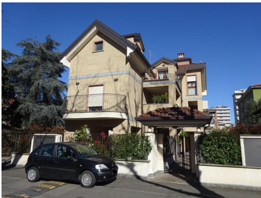
Vista da via Cadore – ingresso pedonale
