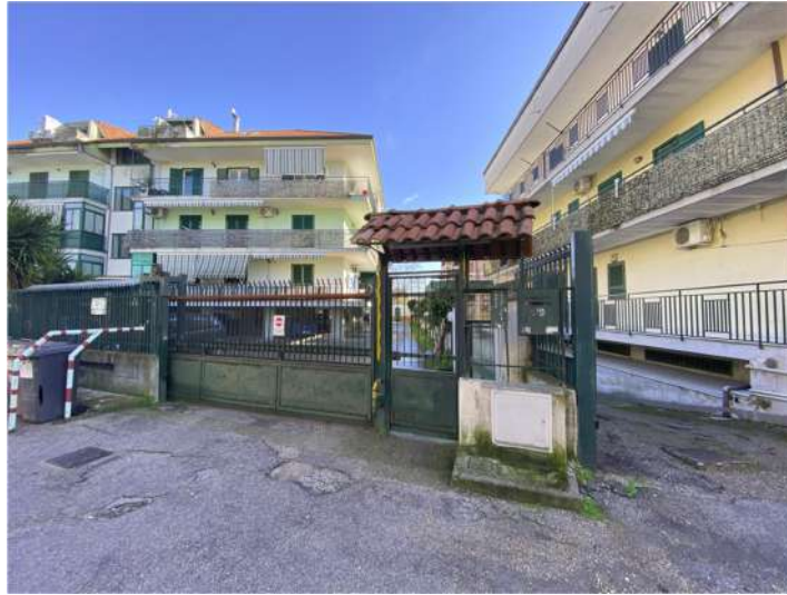
Foto 2: Ingresso lato interno scala B
