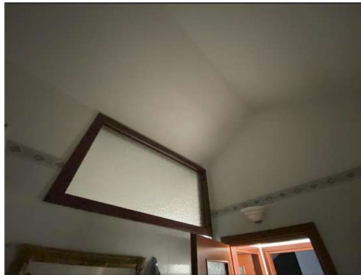
Foto 14: Vista interna veranda
