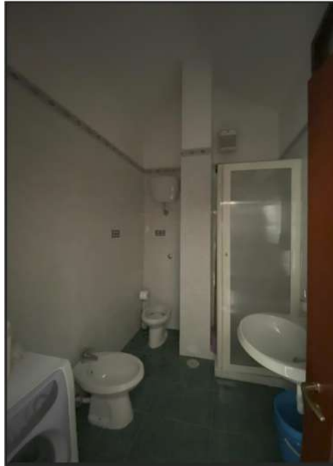
Foto 13: Vista aerazione bagno
