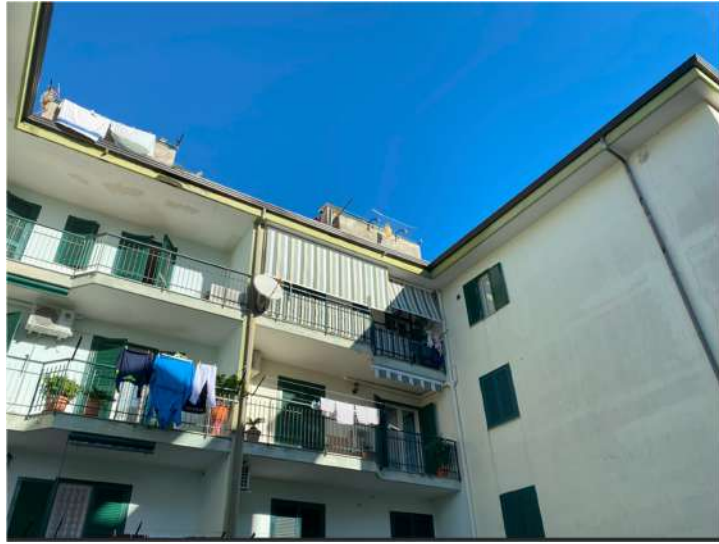
Foto 4: Vista dalla corte esterna condominiale
