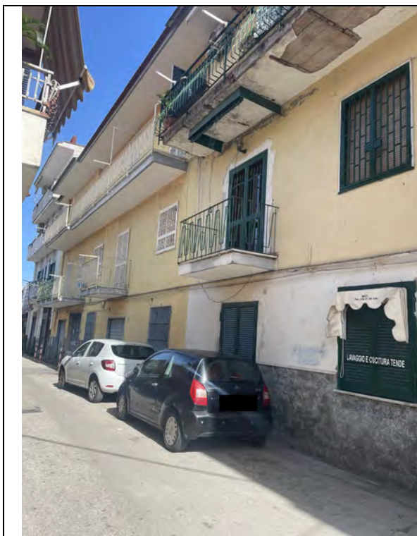
Fotografia n. 1 _ Prospetto su via Giuseppe Garibaldi
