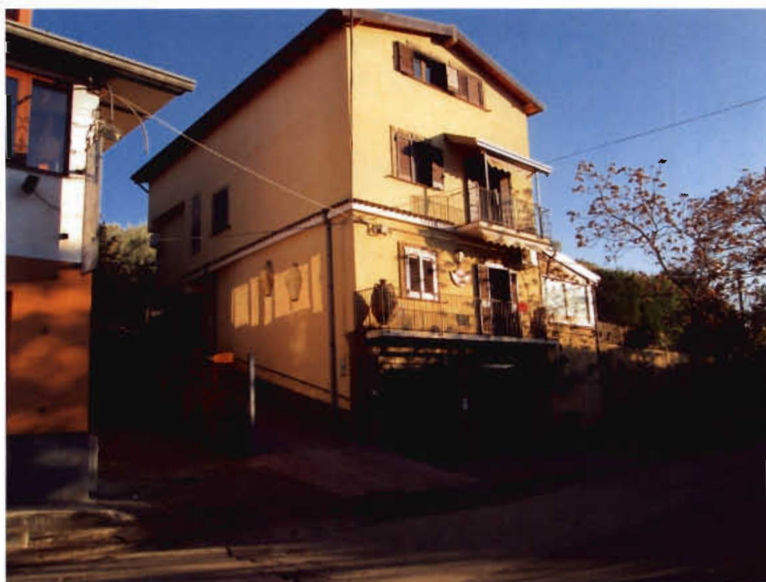
Foto n.4 ingresso all'immobile da rampa adiacente al fabbricato
