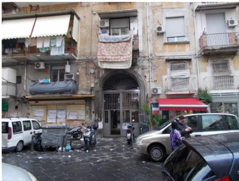
Ingresso civico 221 ed affacci dell'appartamento ubicati superiormente all'ingresso dello stabile (piano 2°)
