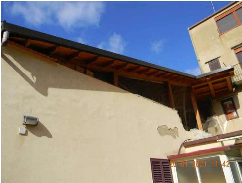
FOTO 10 - Vista della nuova copertura lignea.
