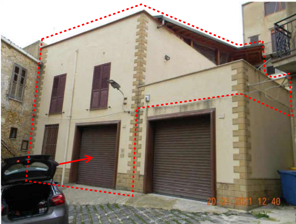
FOTO 02 - Prospetto e accesso al magazzino sulla via Malfitano.
