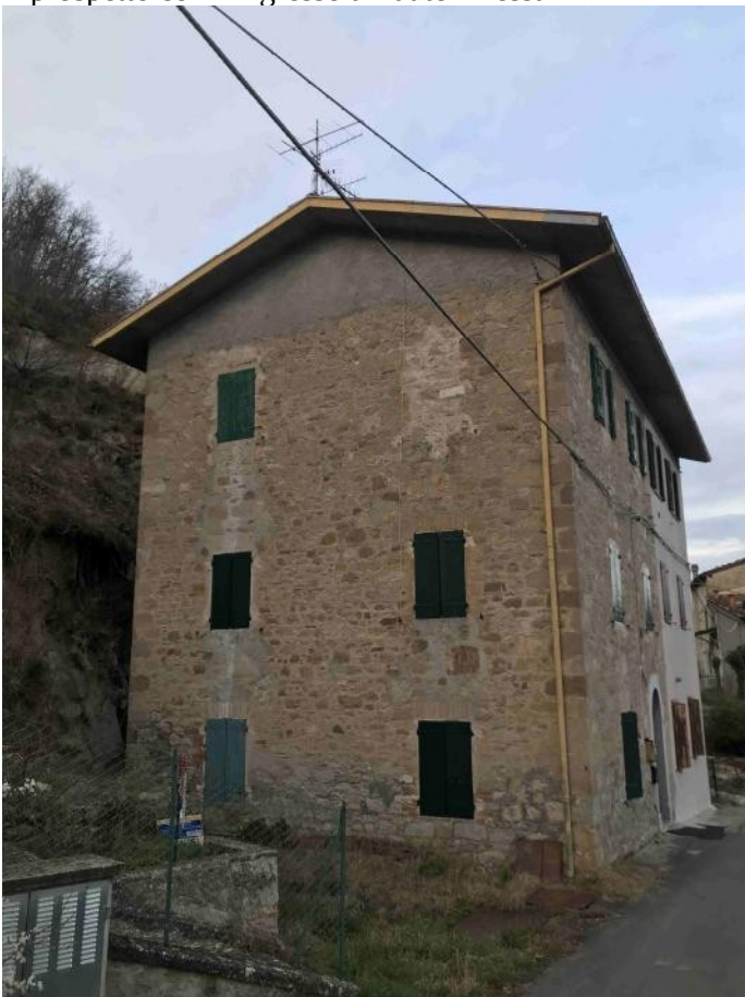
Il prospetto laterale dell'edificio
