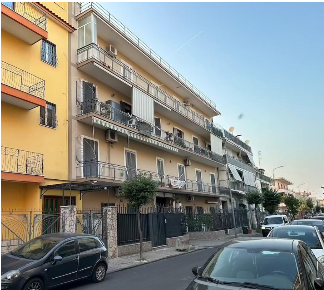
Foto n.1 – Panoramica fabbricato lato strada
