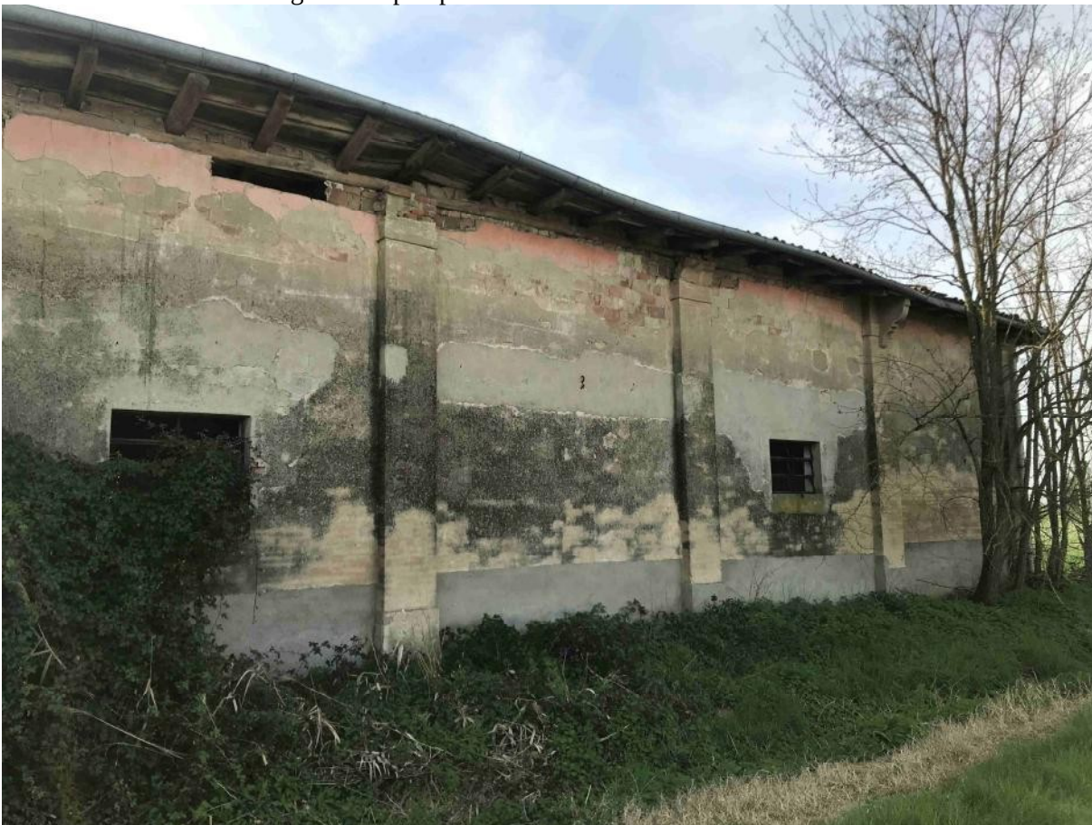
Vista dell'edificio ad uso agricolo – prospetto nord-ovest
