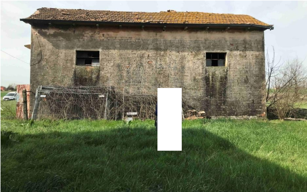
Vista dell'edificio ad uso rimessa-magazzino – prospetto nord-est
