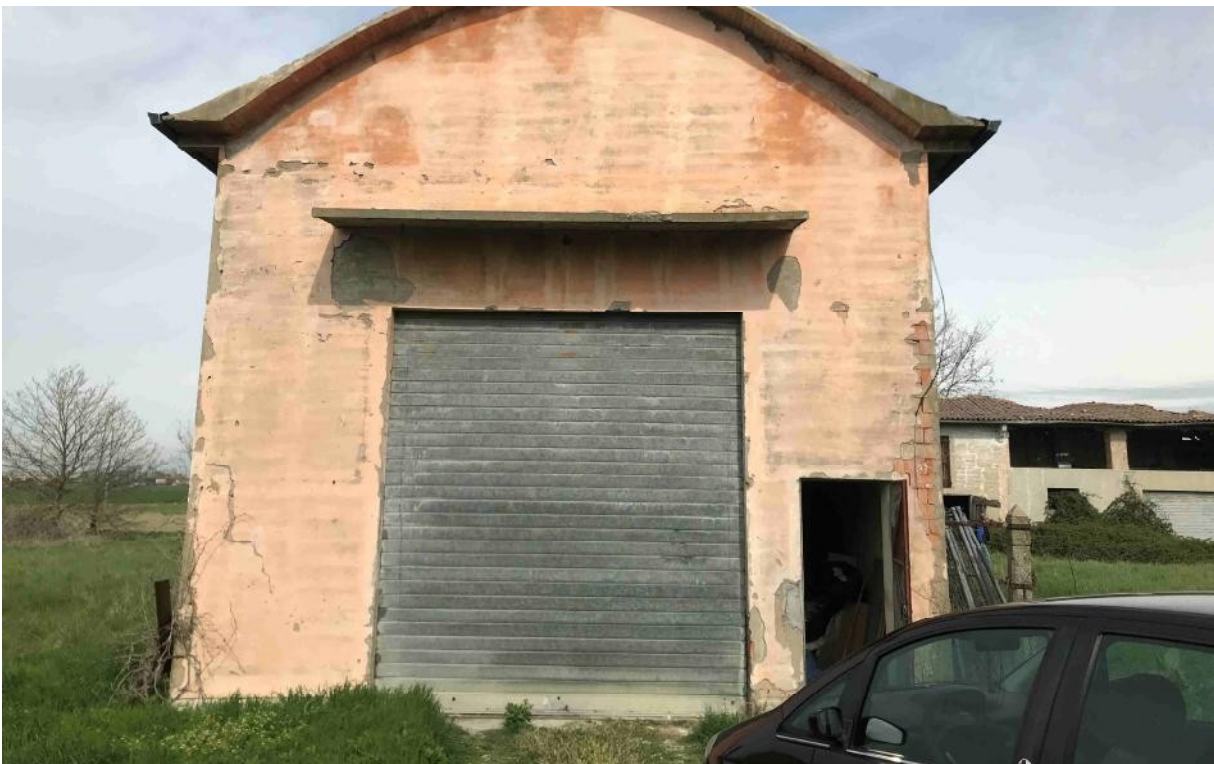
Prospetto principale dell'edificio ad uso rimessa-magazzino
