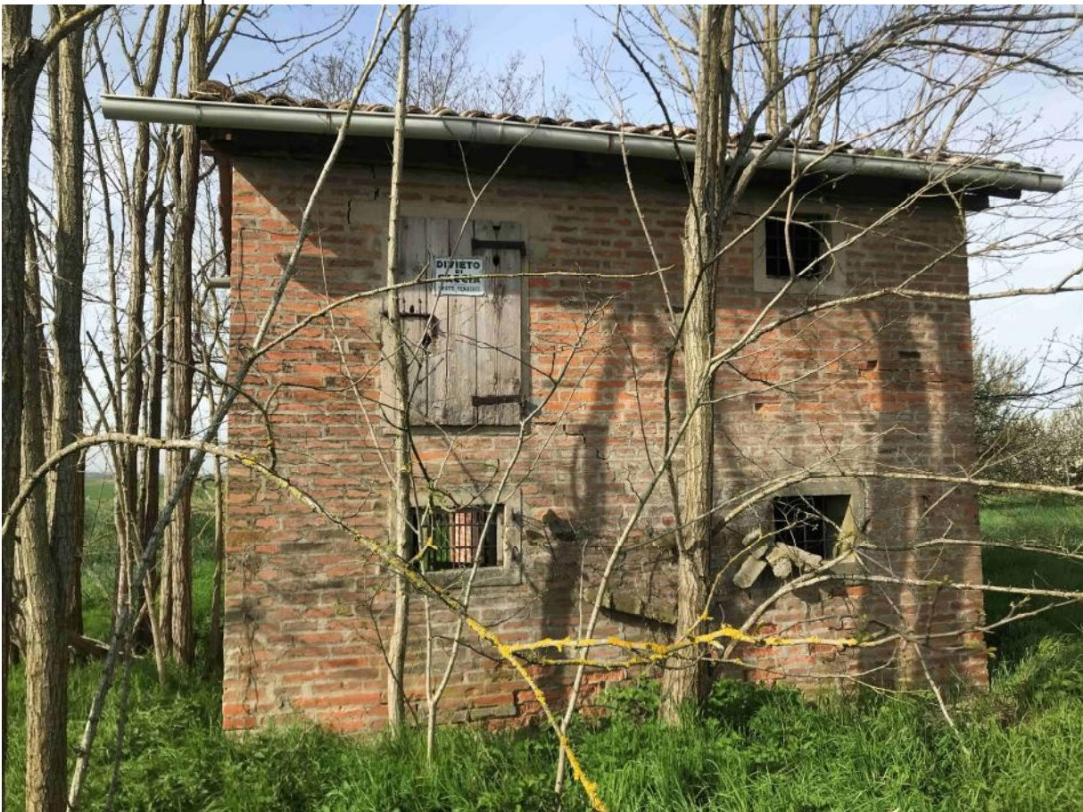
Vista dell'edificio pollaio-forno – prospetto laterale nord-est
