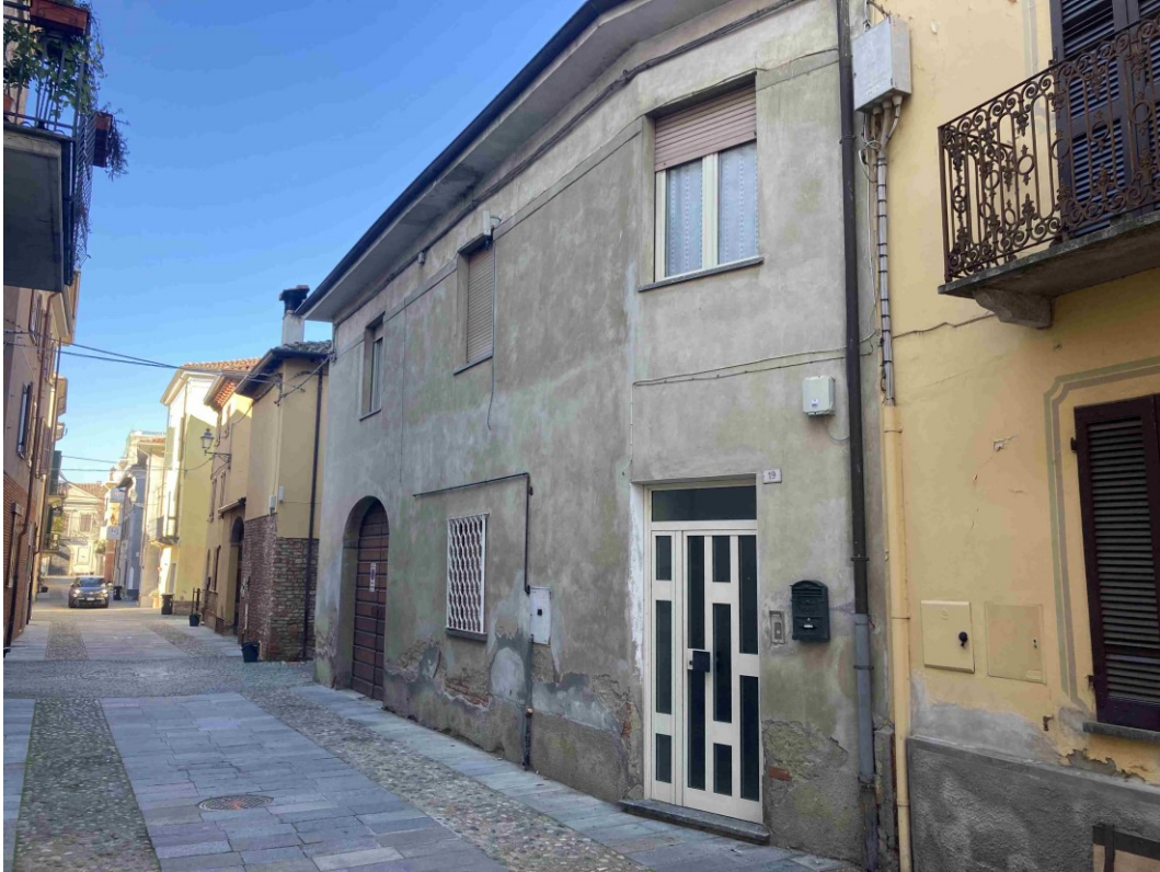
Foto 1 – Prospetto da Via Roma
