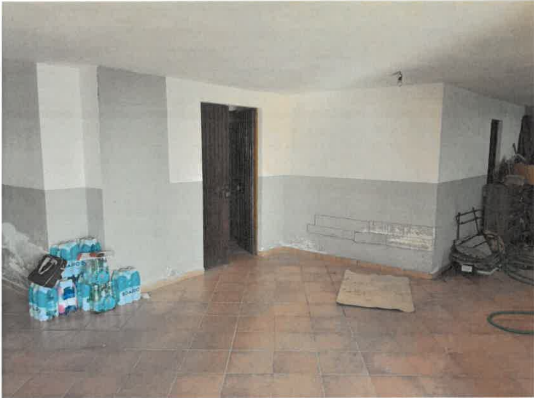
FOTO 5 – Altra vista locale adibito a box
