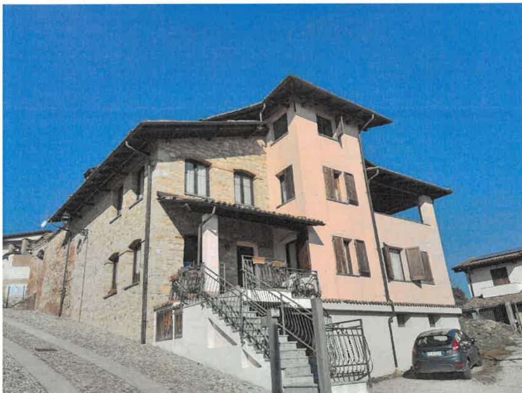
FOTO 1 – Vista esterna da Via Castello lato Sud-Est
