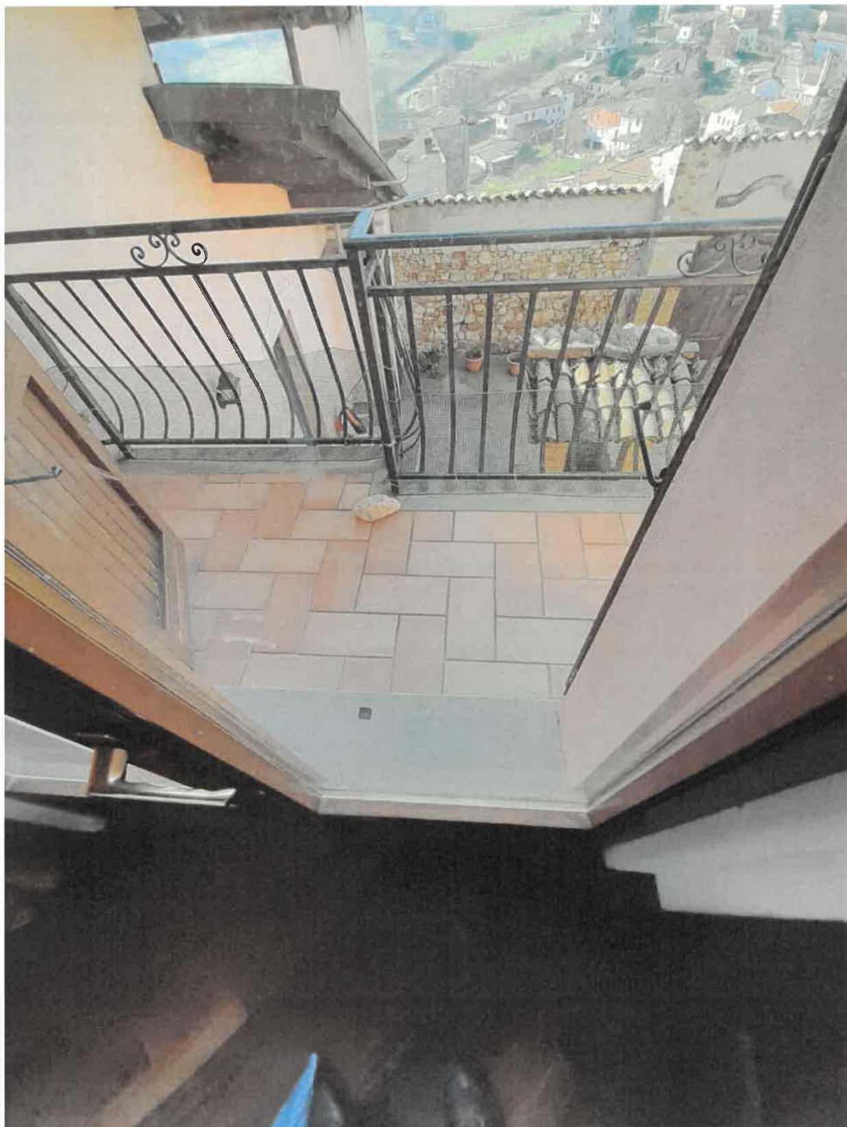
FOTO 16 – Vista dall'interno scorcio balcone e cortile
