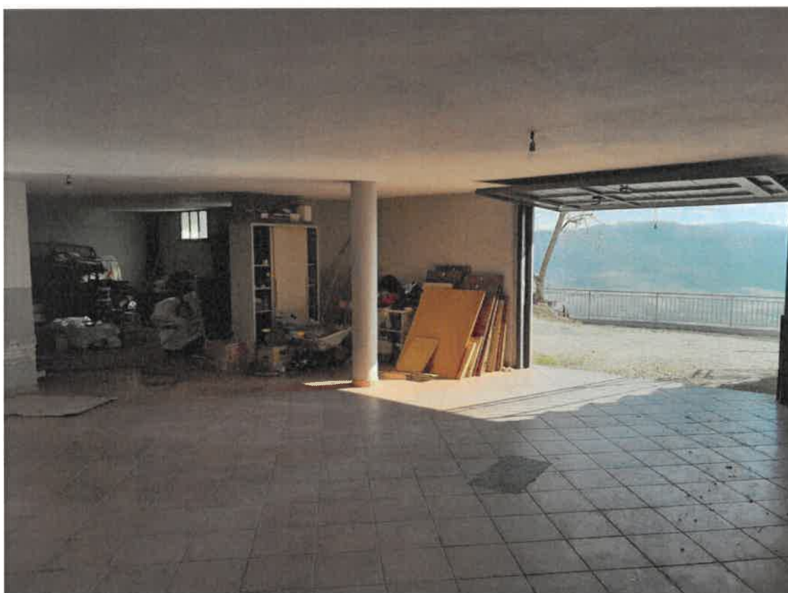
FOTO 4 – Vista box piano interrato
