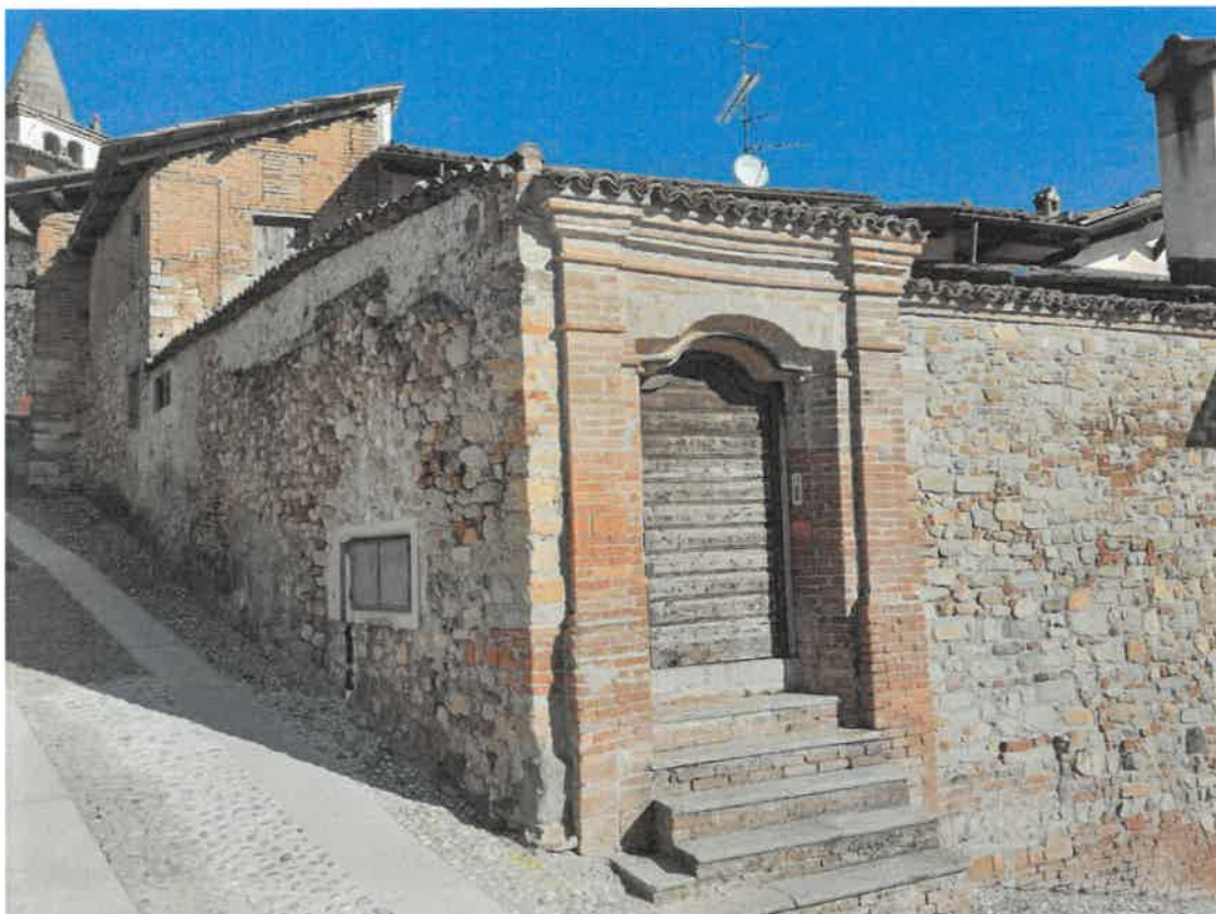
FOTO 3 – Vista esterna da Via Castello lato Sud-Ovest
