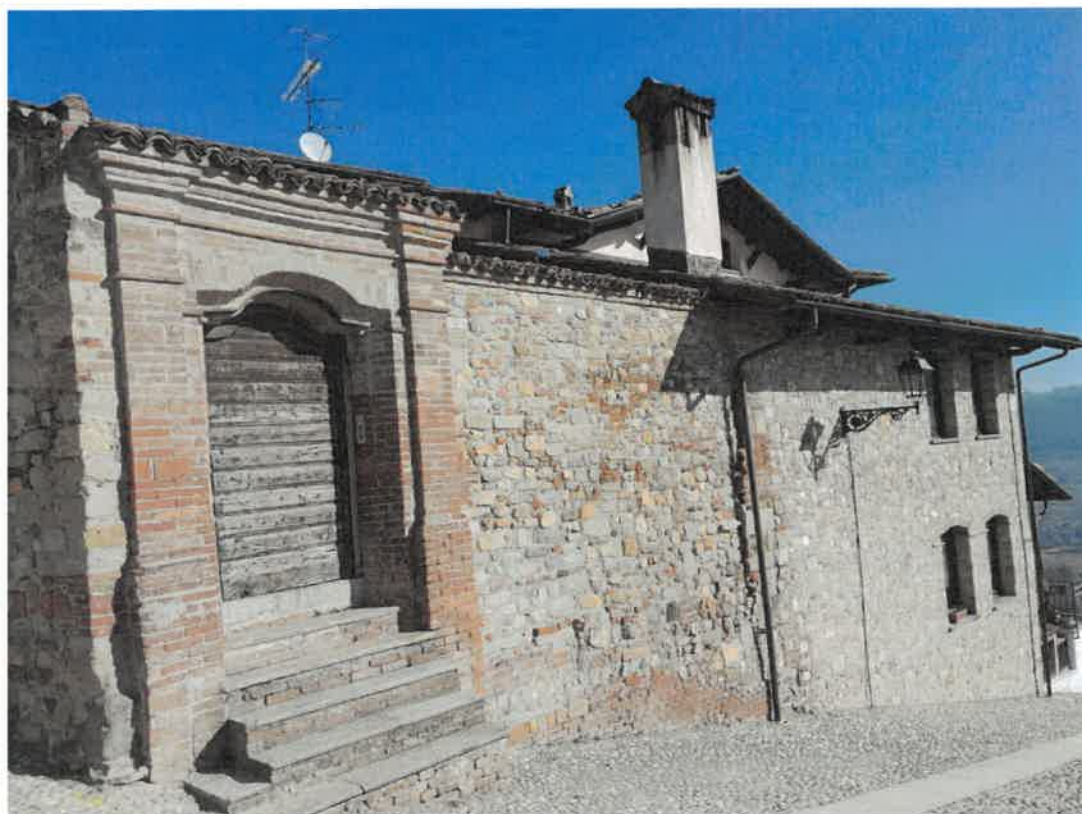
FOTO 2 – Vista esterna da Via Castello lato Sud
