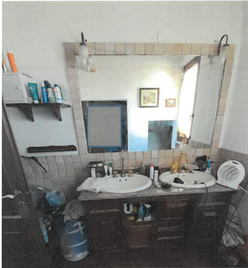
FOTO 14 – Vista interno bagno – Zona lavelli
