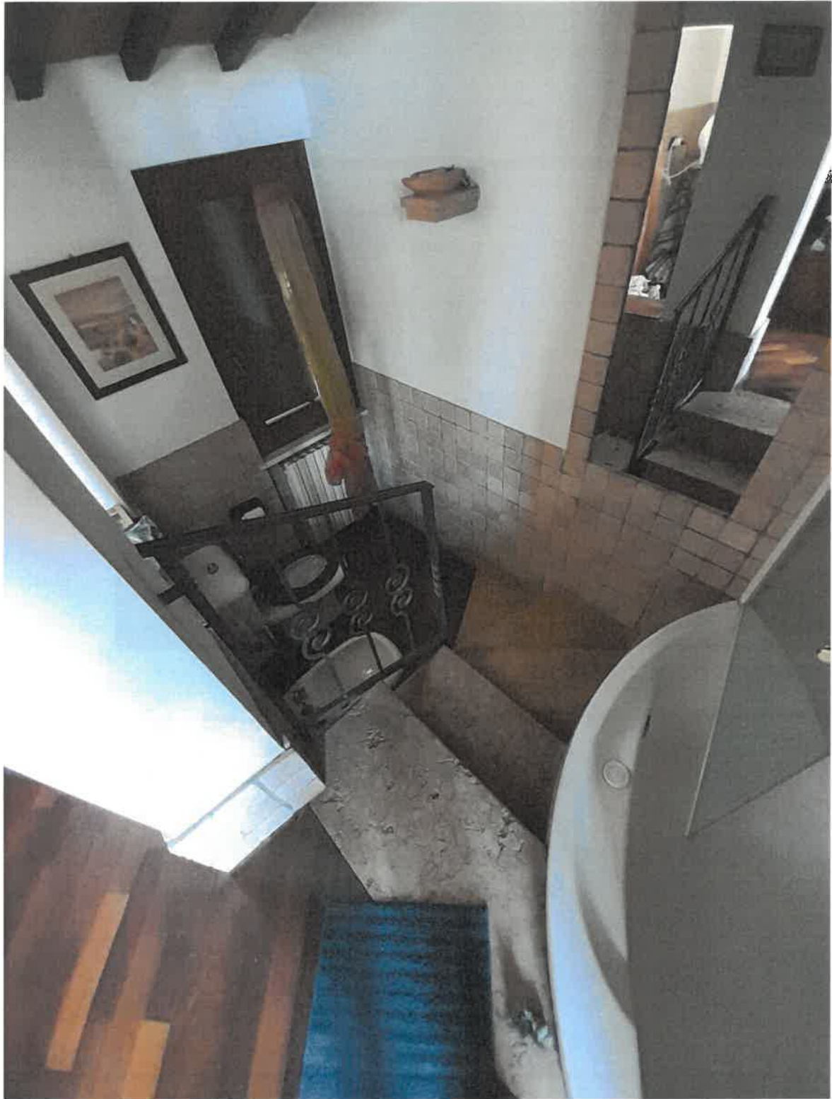
FOTO 13 – Vista interno bagno
