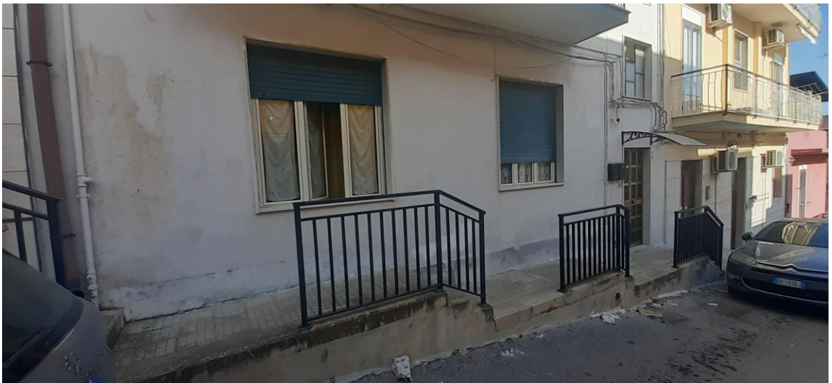
FOTO N. 2 – PROSPETTO SU VIA BOCCACCIO
