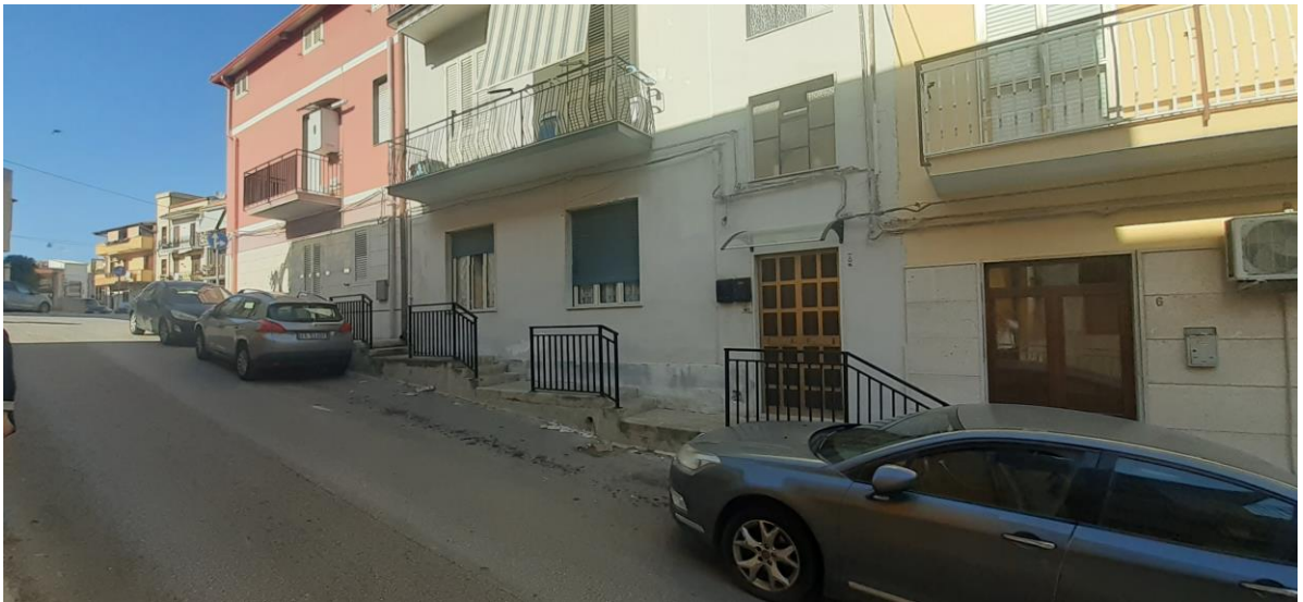
FOTO N. 1 – PROSPETTO SU VIA BOCCACCIO
