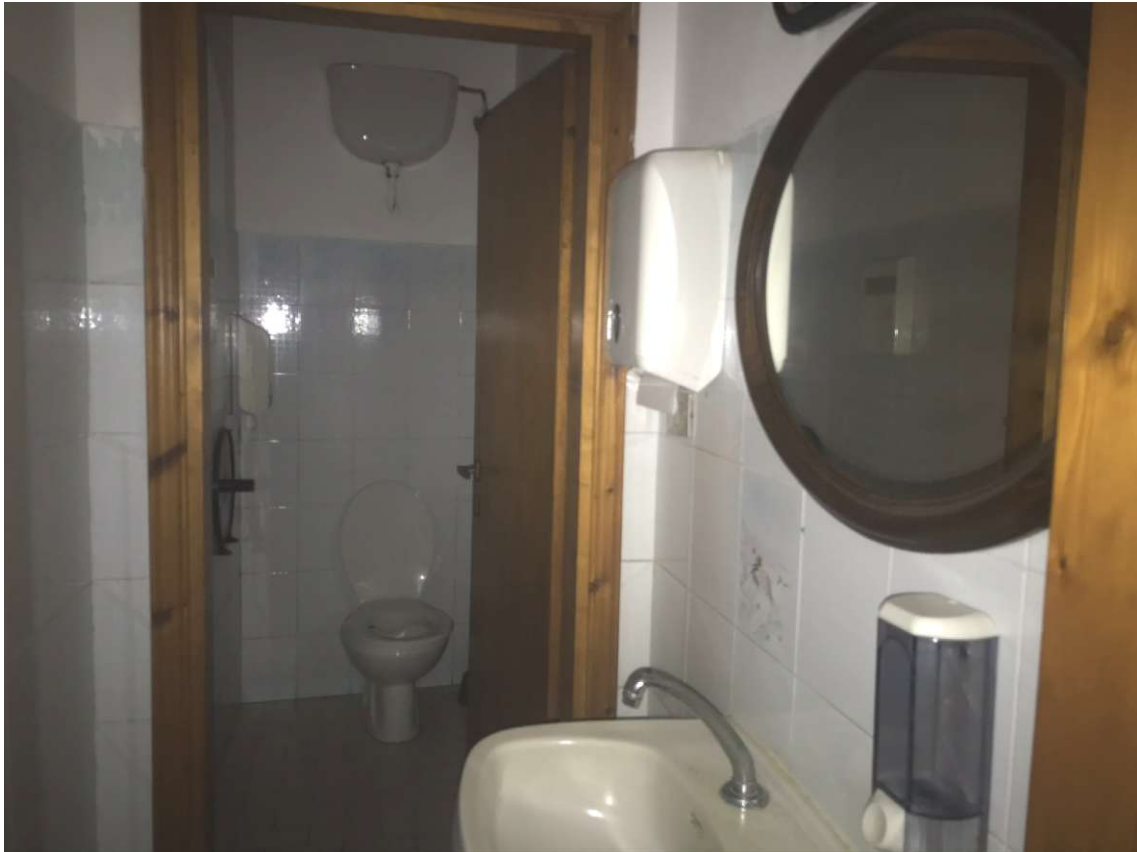
Vista servizio igienico e disimpegno
