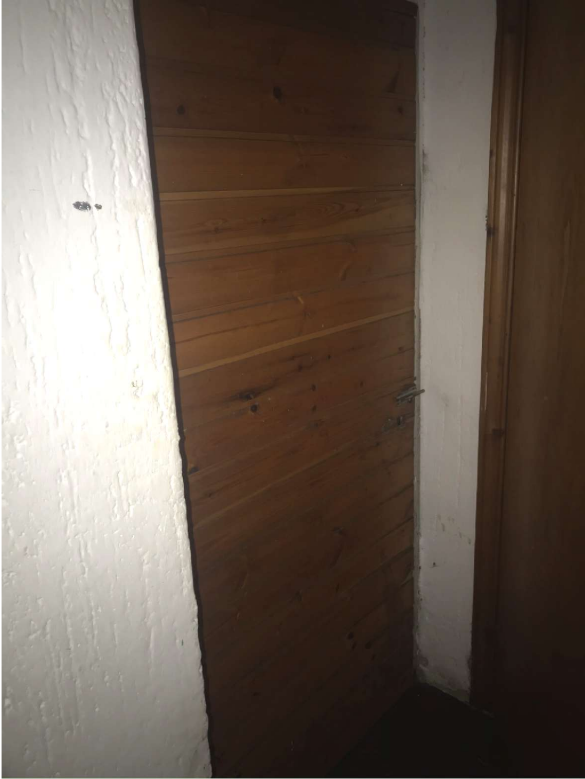
Vista porta di accesso alla cantina
