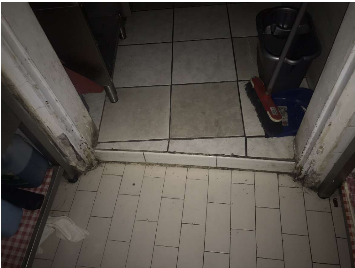
Pavimentazione disimpegno - cucina
