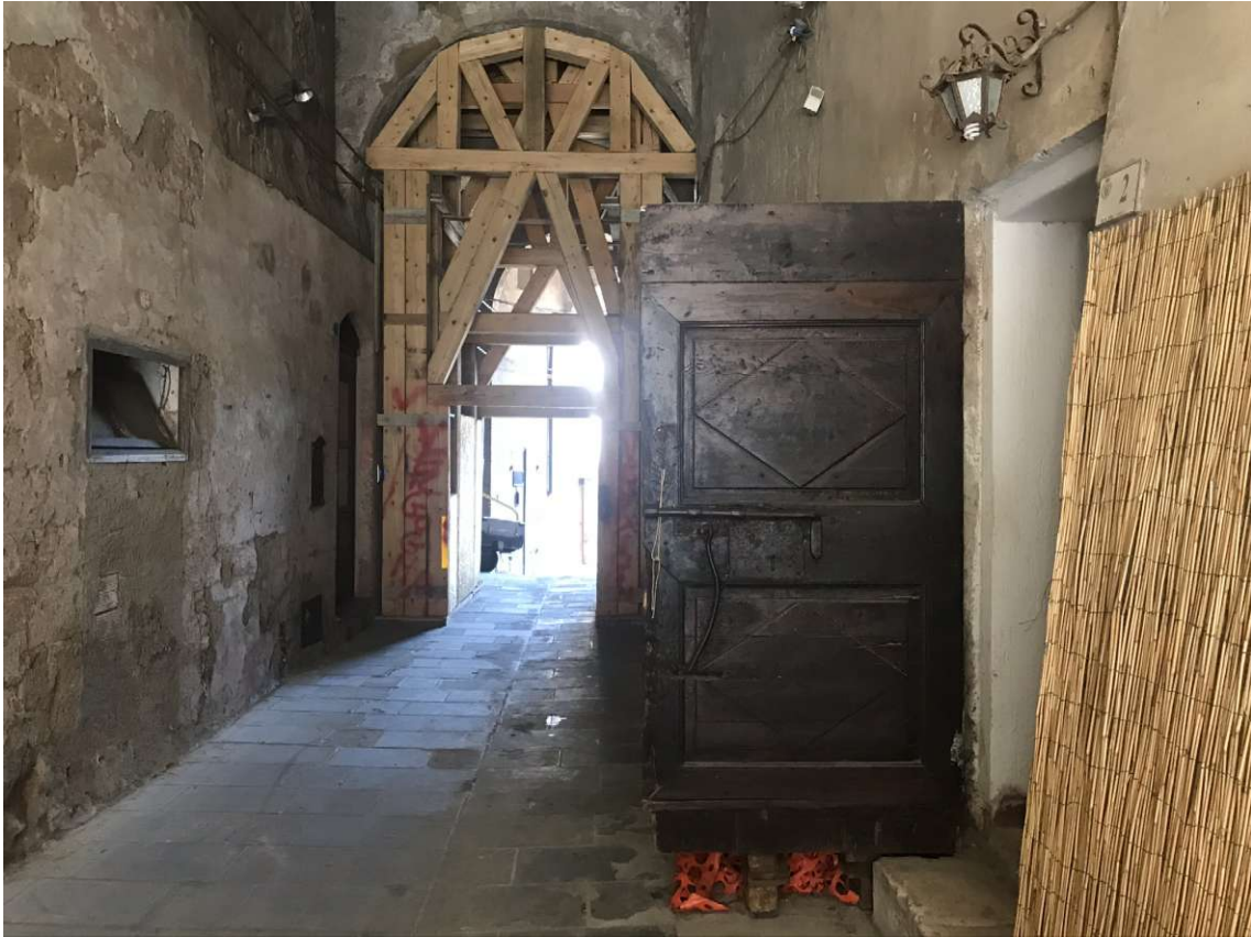
Vista galleria di Via dell'Arco
