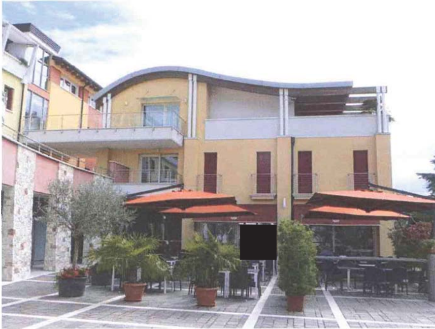
3 Prospetto ovest del volume E
