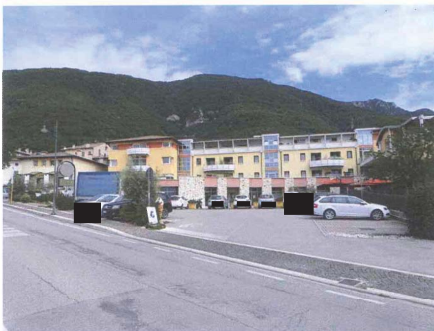
1 Veduta da Via Piave del complesso immobiliare condominio "Orizzonti"
