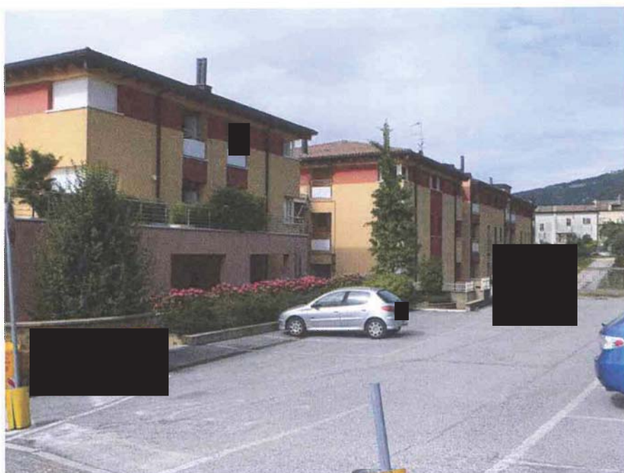
8 Prospetto nord del condominio
