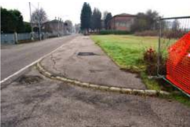
foto 7 - Scorcio del marciapiede con pista ciclabile
