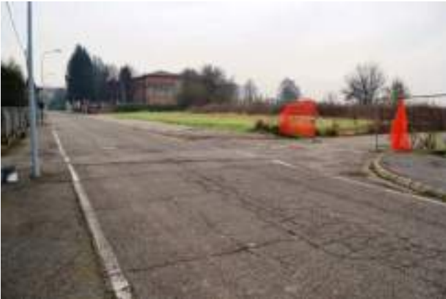
foto 5 - Vista del tratto sud ovest di via Don Tressino
