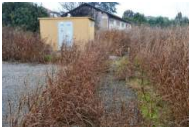
foto 18 - Scorcio della cabina elettrica sul m.n. 275
