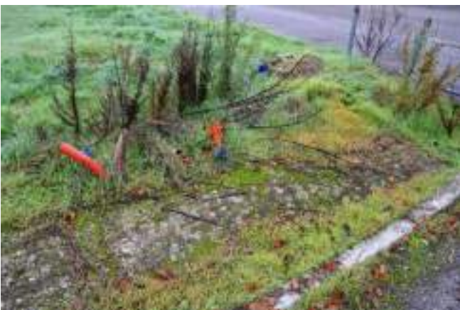
foto 22 - Particolare delle derivazioni degli impianti
