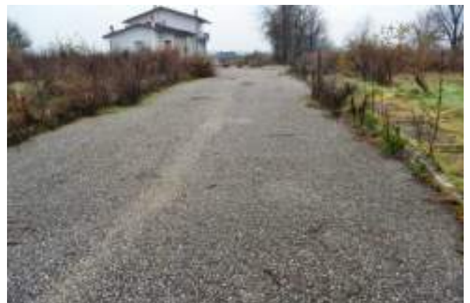
foto 8 - Vista dell'accesso stradale da via Don Tressino
