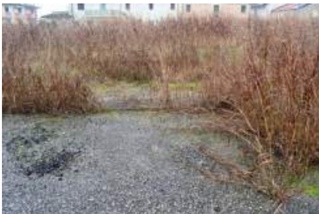
foto 17 - Particolare del marciapiede stradale sud
