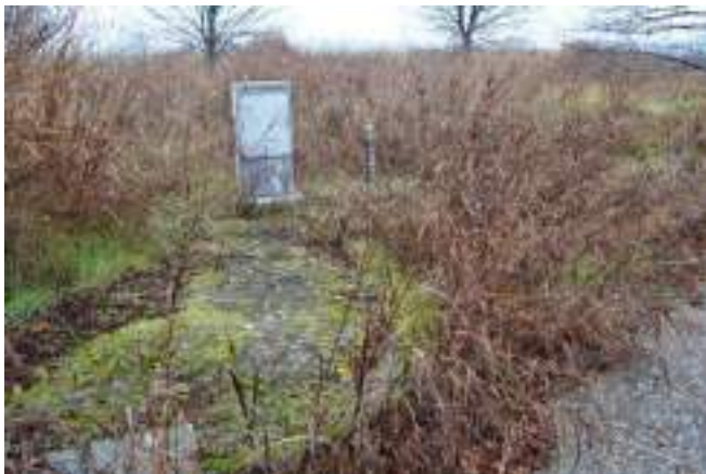
foto 15 - Particolare del marciapiede con parcheggio
