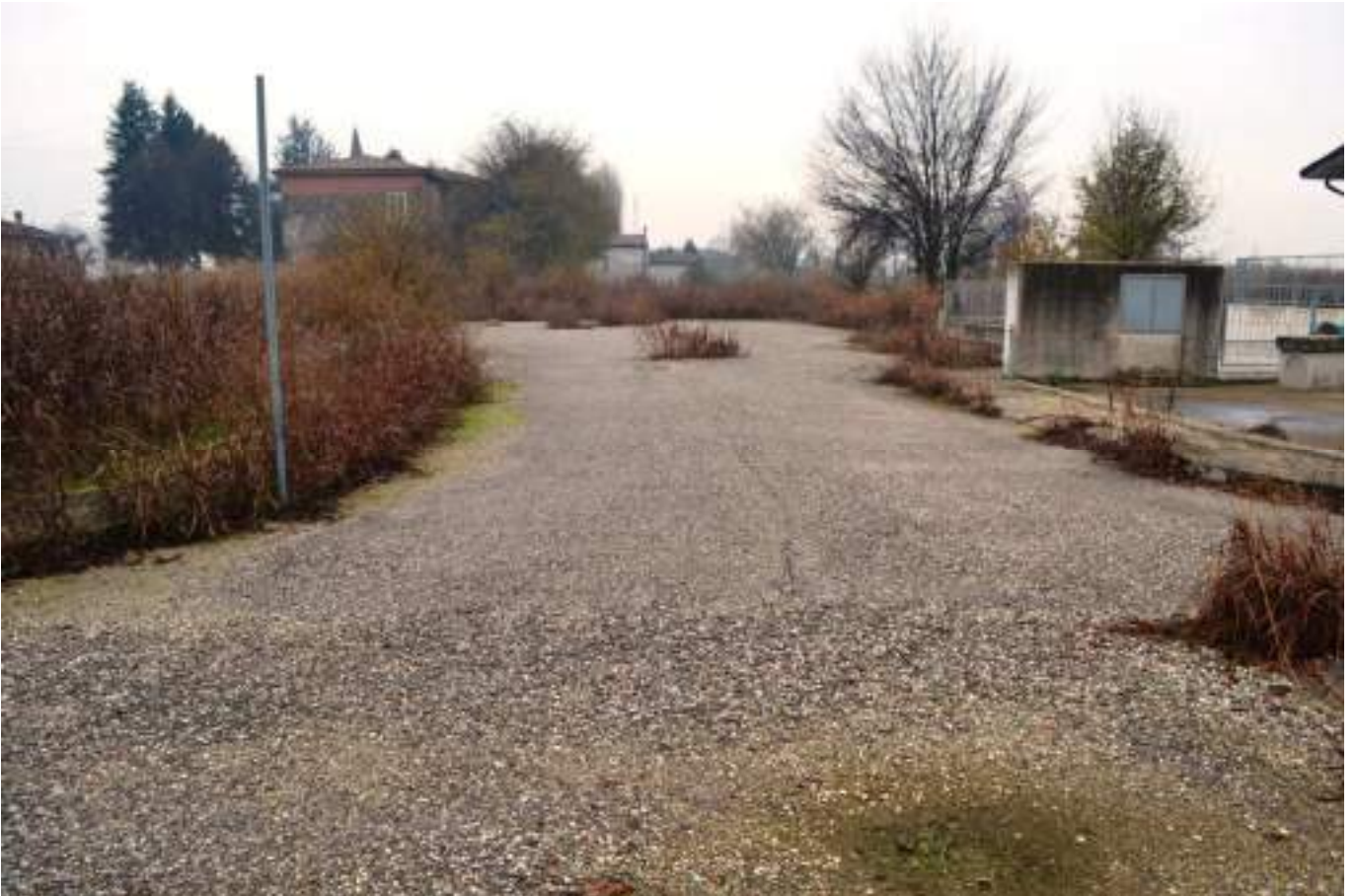
foto 19 - Vista del tratto ovest della strada interna (cieca con manovra) del PUA ORTI, visto da est
